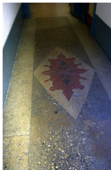
Sol de l'allée Phot. Bernard Ducouret IVR82_20046900153NUCA
