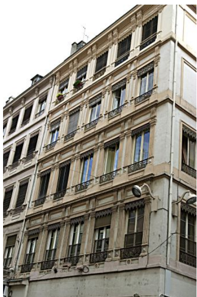
Façade principale, élévation des étages carrés Phot. Maryannick Chalabi IVR82_20046900151NUCA
