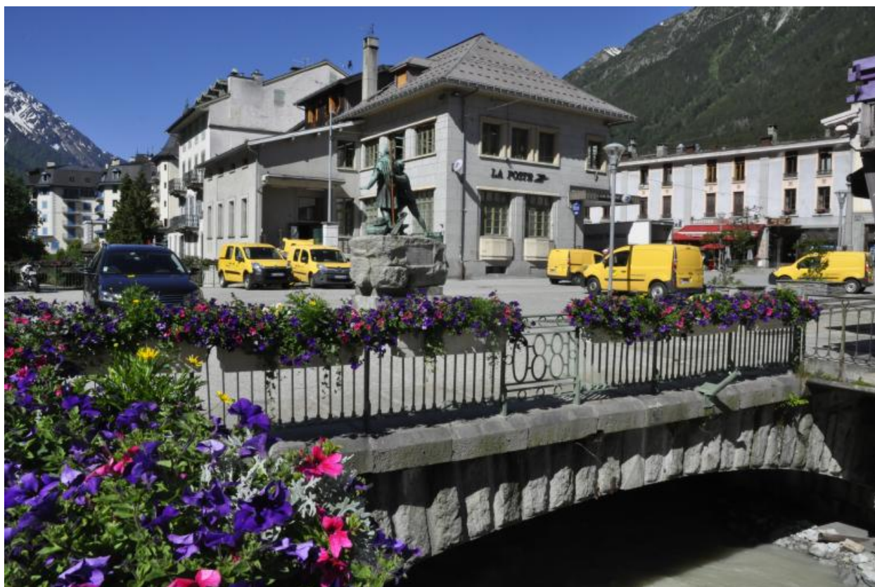
Vue de la face amont de l'ouvrage
