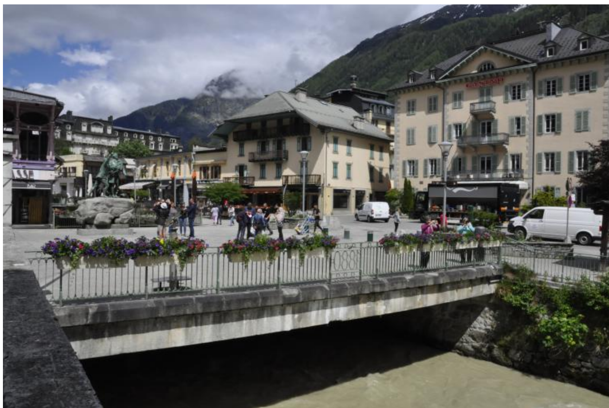
Vue de la face aval du pont
