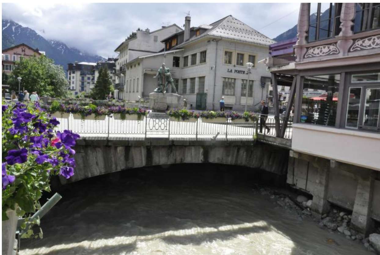
Autre vue dela face amont de l'ouvrage
