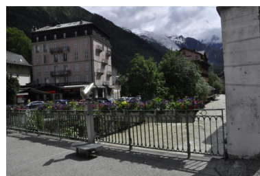
Garde-corps en face aval Phot. Samir Mahfoudi IVR84_20207401345NUCA
