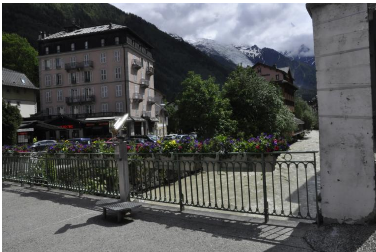
Garde-corps en face aval
