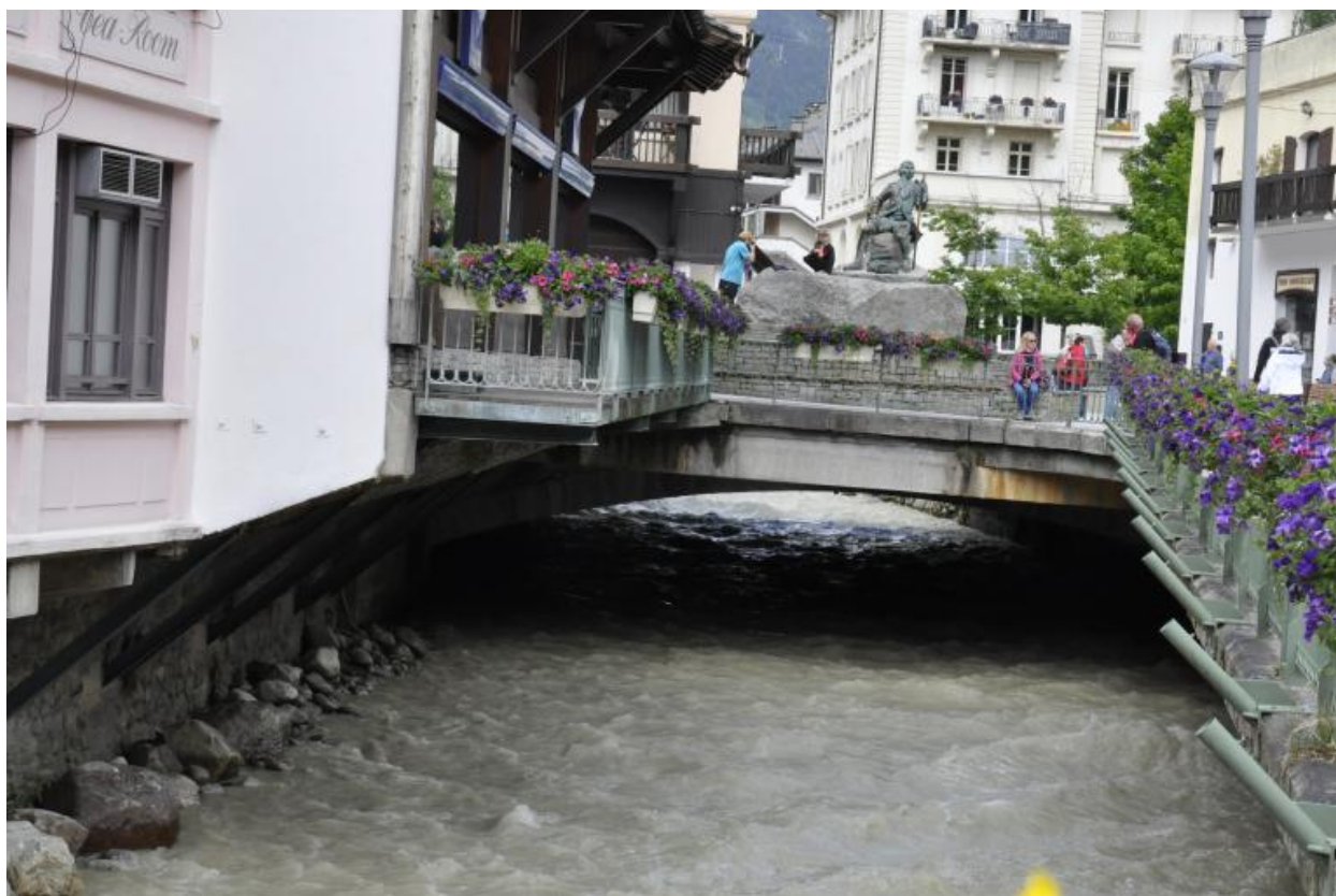
Vue générale de l'ouvrage
