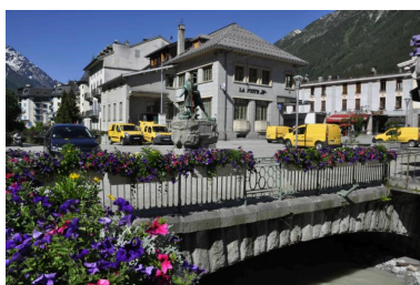
Vue de la face amont de l'ouvrage Phot. Samir Mahfoudi IVR84_20207401341NUCA
