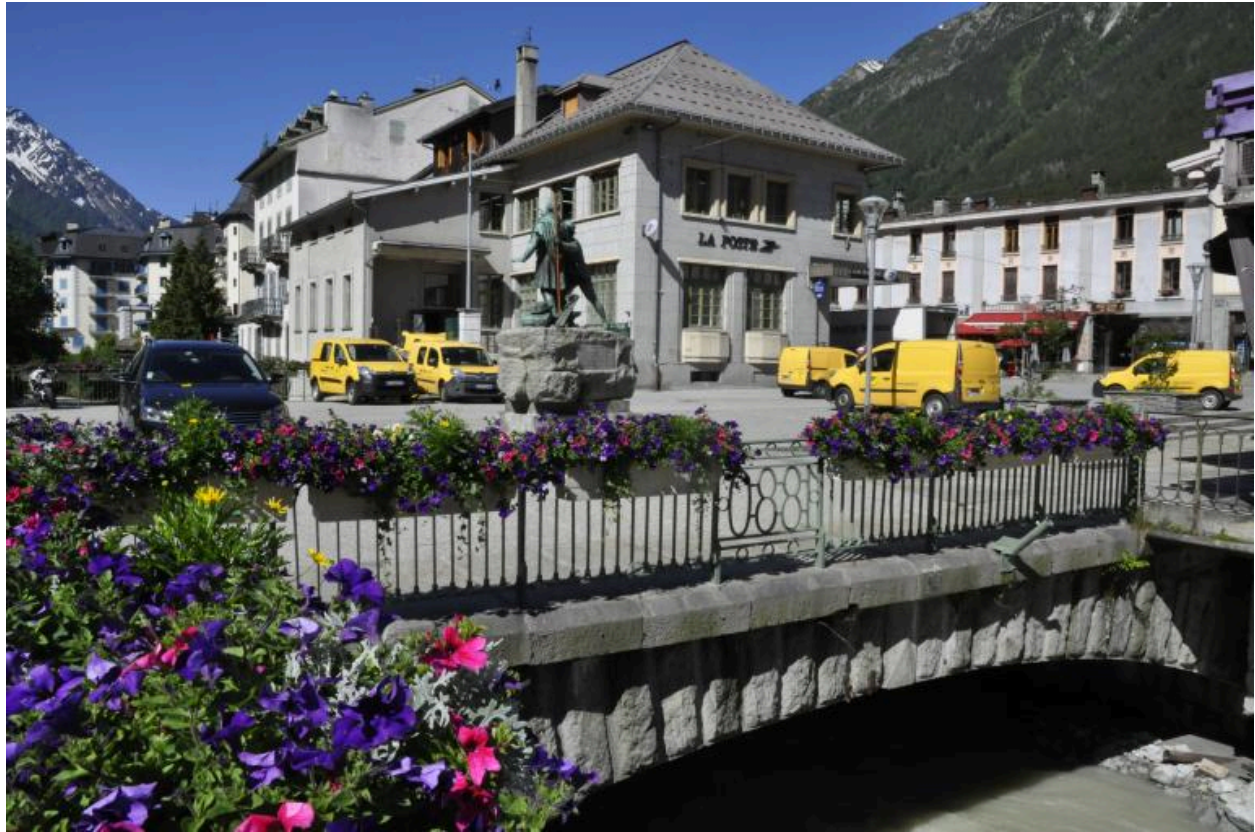
Vue de la face amont de l'ouvrage
