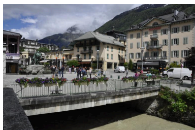
Vue de la face avale du pont Phot. Samir Mahfoudi IVR84_20207401346NUCA
