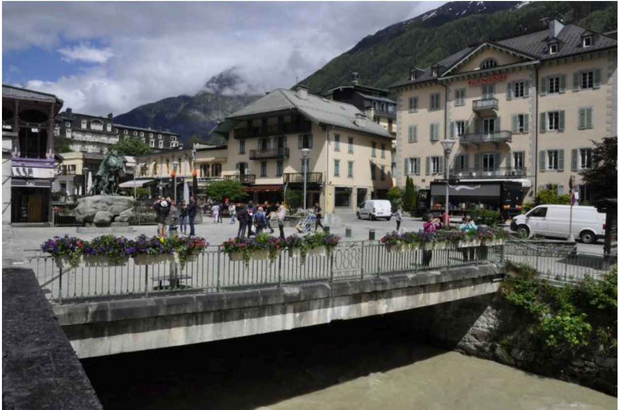
Vue de la face aval du pont
