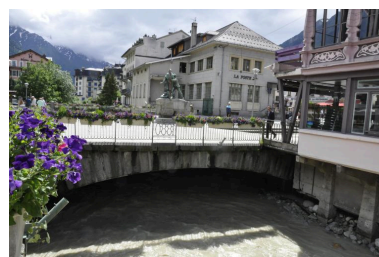
Autre vue de la face amont de l'ouvrage Phot. Samir Mahfoudi IVR84_20207401342NUCA
