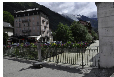
Garde-corps en face avale Phot. Samir Mahfoudi IVR84_20207401345NUCA
