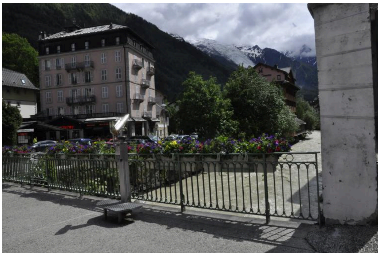
Garde-corps en face aval
