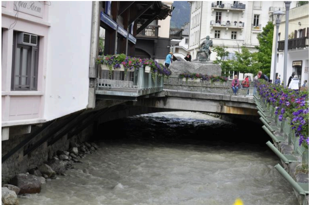
Vue générale de l'ouvrage
