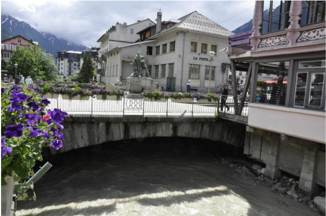
Autre vue dela face amont de l'ouvrage
