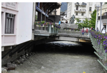
Vue générale de l'ouvrage Phot. Samir Mahfoudi IVR84_20207401347NUCA
