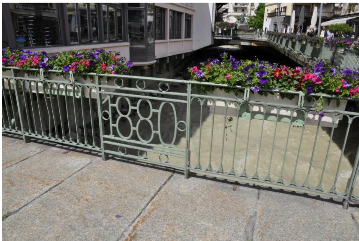
Détail du garde-coprs avec date portée
