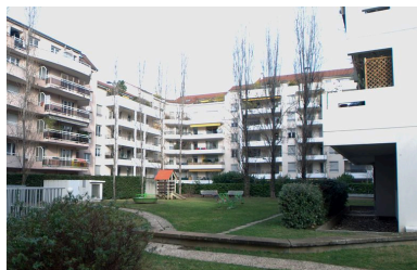
Elévation postérieure Phot. Maryannick Chalabi IVR82_20116904126NUCA
