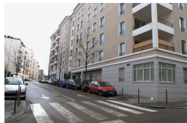
Elévation rue Jules- Brunard, depuis l'ouest Phot. Maryannick Chalabi IVR82_20116904124NUCA
