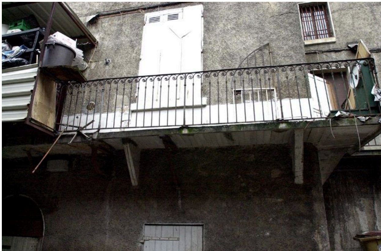
Détail du garde-corps en ferronnerie de la coursière sur cour
