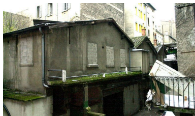
Vue des bâtiments construits à l'est de la cour Phot. Maryannick Chalabi IVR82_20016900109NUCA
