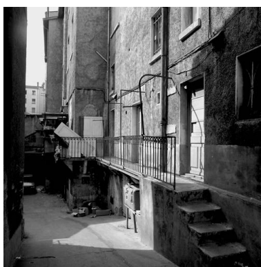
Vue de la cour Phot. Martial Couderette IVR82_20016900063X
