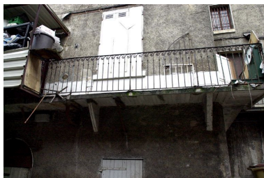
Détail du garde-corps en ferroserie de la coursière sur cour Phot. Maryannick Chalabi IVR82_20016900110NUCA
