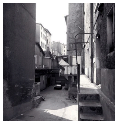
Vue de la cour et des bâtiments construits à l'est Phot. Martial Couderette IVR82_20016900064X
