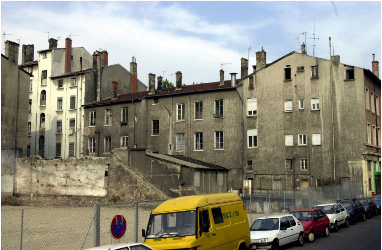
Élévation postérieure après la destruction du 28 rue Dugas-Montbel
