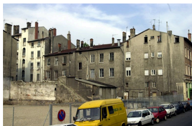
Elévation postérieure après la destruction du 28 rue Dugas-Montbel Phot. François Blanchetière IVR82_20016902068NUCA
