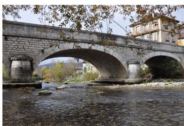
Rivière le Guiers aux Echelles Phot. Yannick Milleret IVR82_20117302157NUCA
