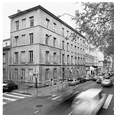
Elévation latérale rue de Bonnel Phot. Didier Gourbin IVR82_20036903734X
