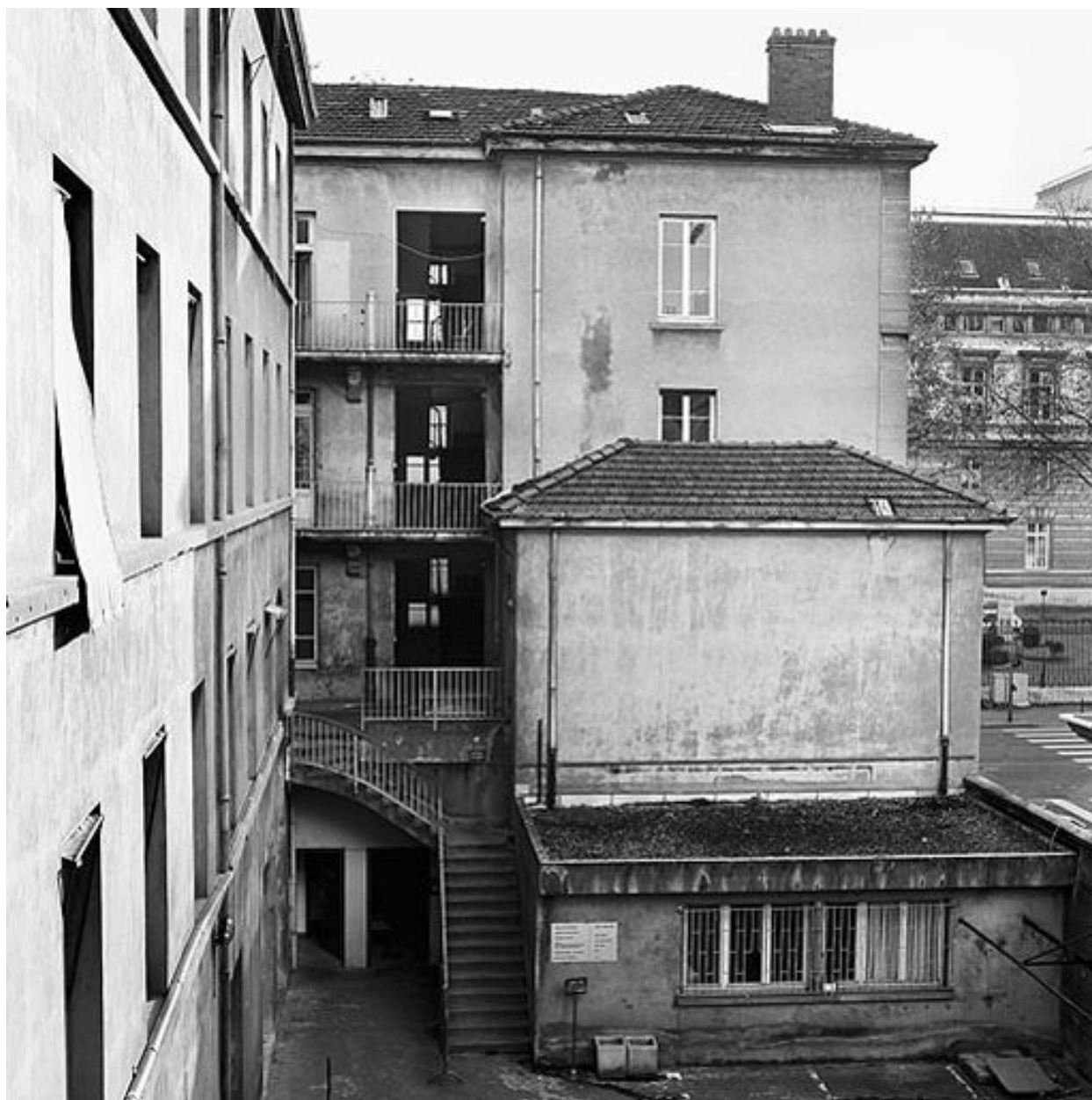
Corps de bâtiment sud et sa cage d'escalier
