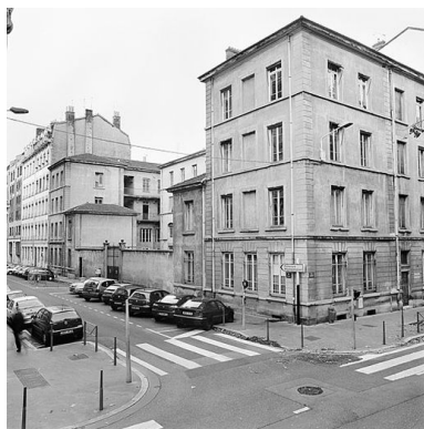
Elévation antérieure sur la rue Molière Phot. Didier Gourbin IVR82_20036903732X
