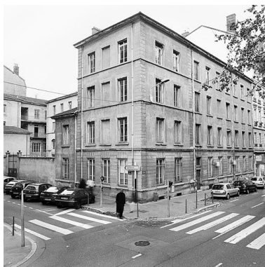
Elévation latérale rue de Bonnel et vue partielle de l'élévation antérieure Phot. Didier Gourbin IVR82_20036903733X
