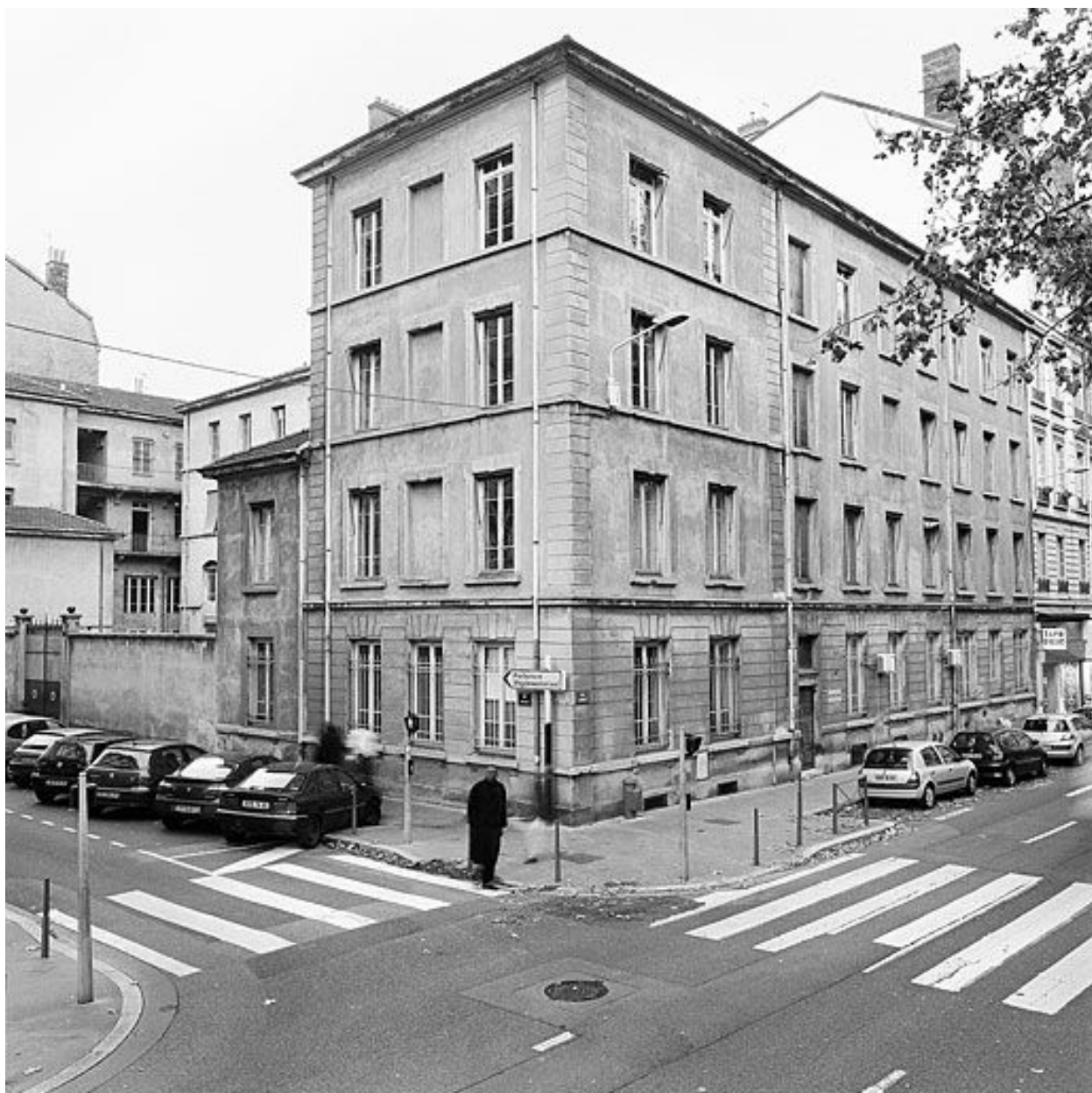
Elévation latérale rue de Bonnel et vue partielle de l'élévation antérieure
