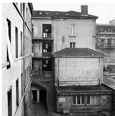
Corps de bâtiment sud et sa cage d'escalier Phot. Didier Gourbin IVR82_20036903735X
