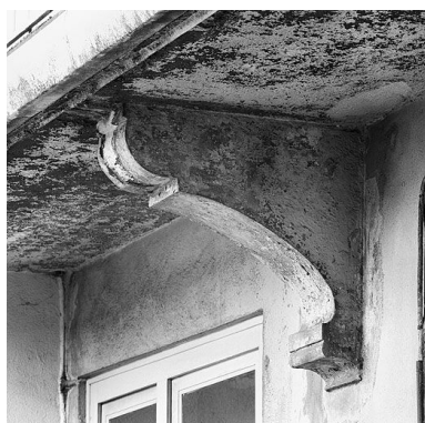
Détail d'une console soutenant une coursière, corps de bâtiment sud Phot. Didier Gourbin IVR82_20036903738X
