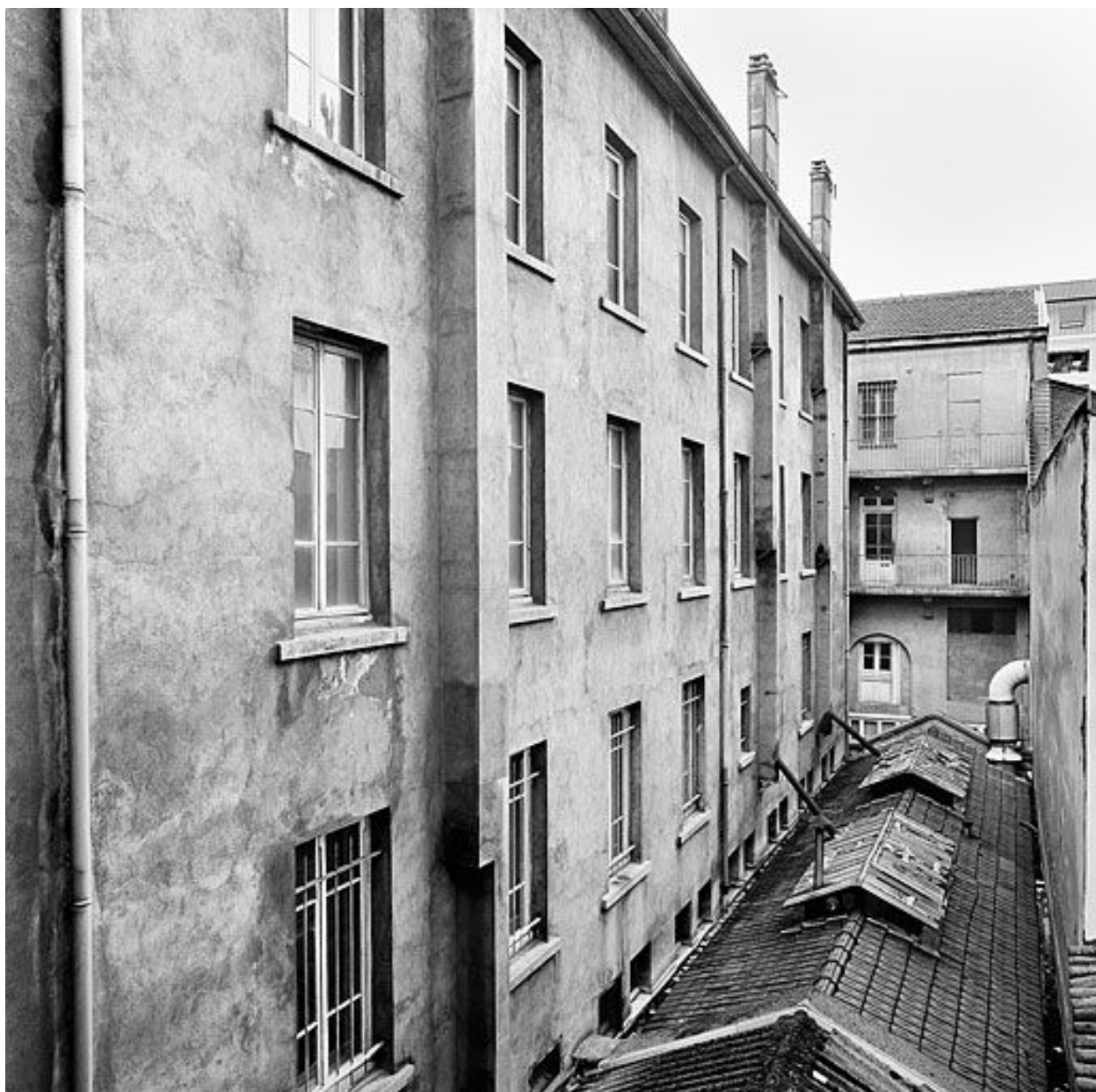
Elévation postérieure du corps de bâtiment central
