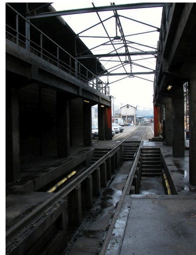
Vue intérieure depuis le sud Phot. Véronique Belle IVR82_20046902189NUCA
