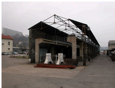
Vue générale depuis le sud est Phot. Véronique Belle IVR82_20046902188NUCA
