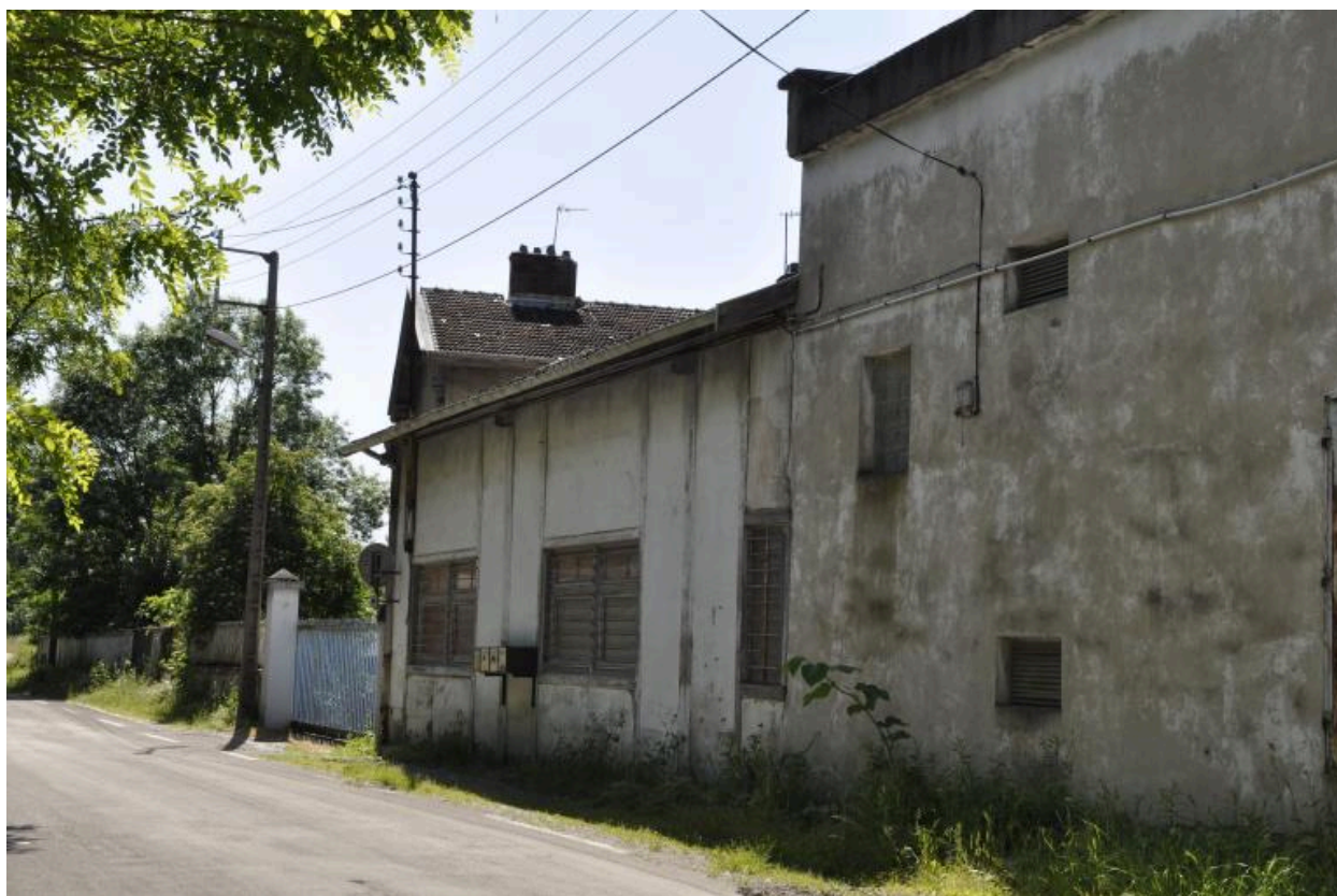
Vue d'ensemble ouest
