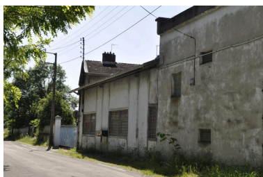
Vue d'ensemble ouest Phot. Nadine Halitim-Dubois IVR84_20166900205NUCA
