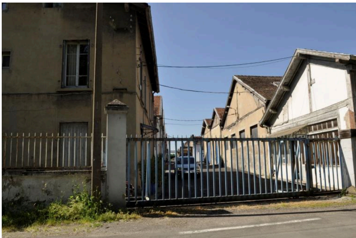
Vue d'ensemble des ancienne usine Lumière sur l'île de la Chèvre à Feyzin
