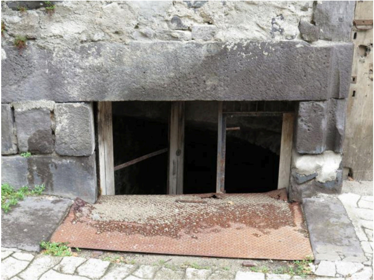
Vue de détail : aération de la cave
