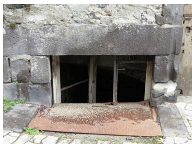
Vue de détail : aération de la cave Phot. Bruno Decrock IVR84_20206300019NUCA
