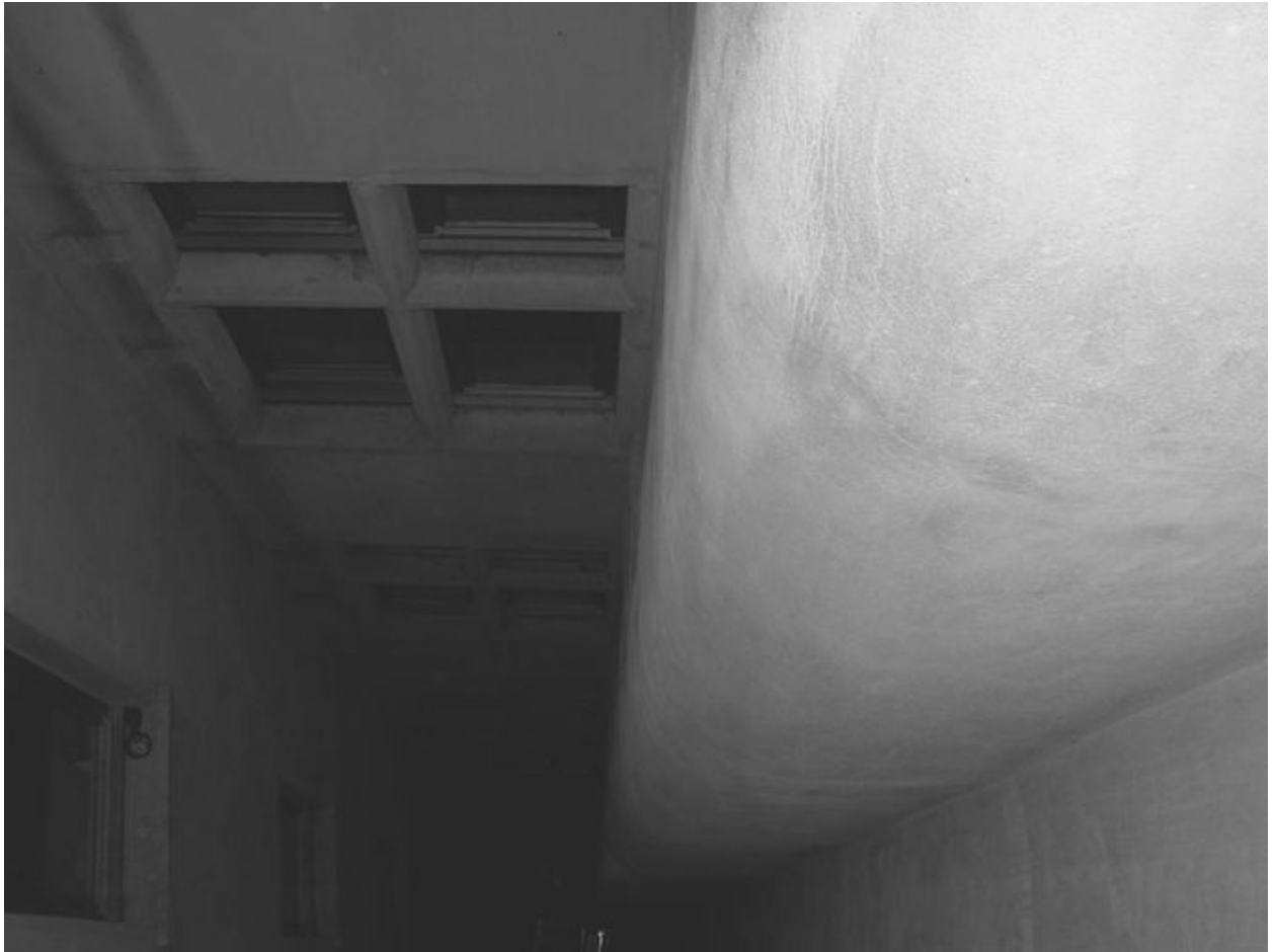
Vue en plongée de la cour depuis la cage d'escalier
