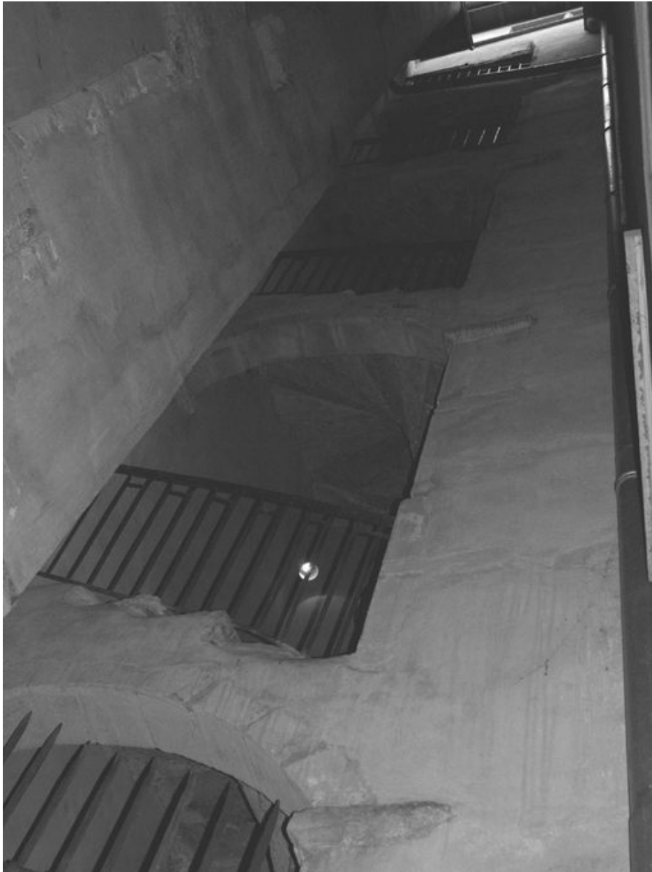
Vue en contre-plongée de la cage d'escalier ouvrant sur le côté est de la cour
