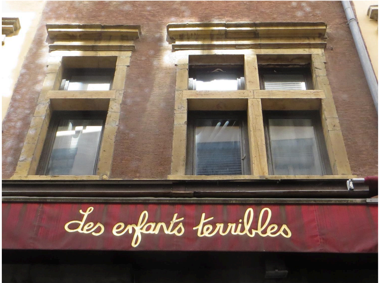
Élévation sur rue : le premier étage carré
