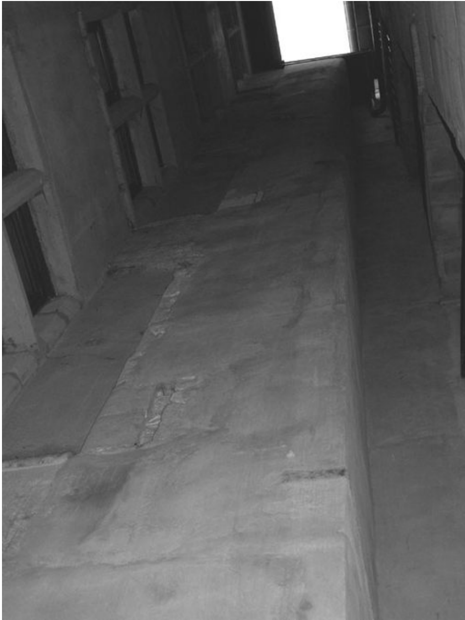
Vue de la cour en contre-plongée
