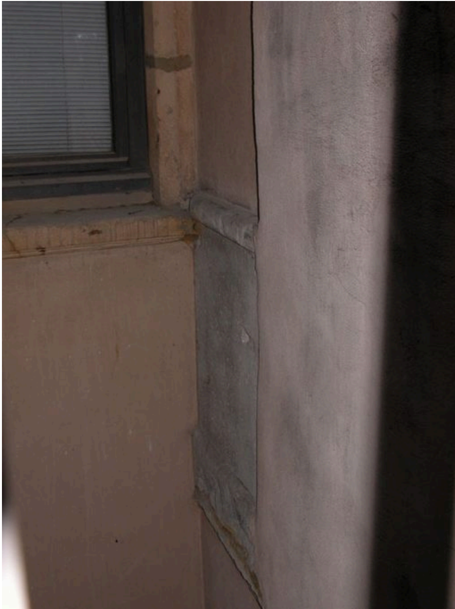
Détail d'un garde-corps de la galerie nord fermée
