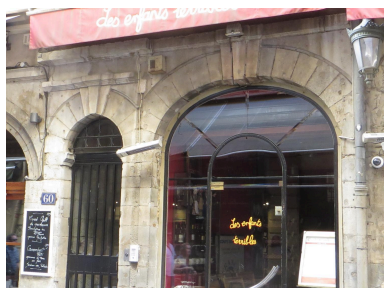
Elévation sur rue : le rez-de-chaussée Phot. Véronique Belle IVR84_20236900542NUCA
