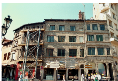
Façade principale Phot. Cendrine Sanquer IVR82_19974201897ZE
