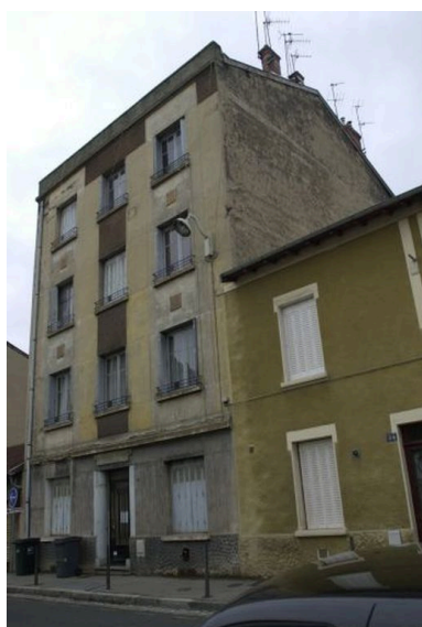
Vue générale de l'élévation depuis le sud-ouest Phot. Maryannick Chalabi IVR82_20046903239NUCA
