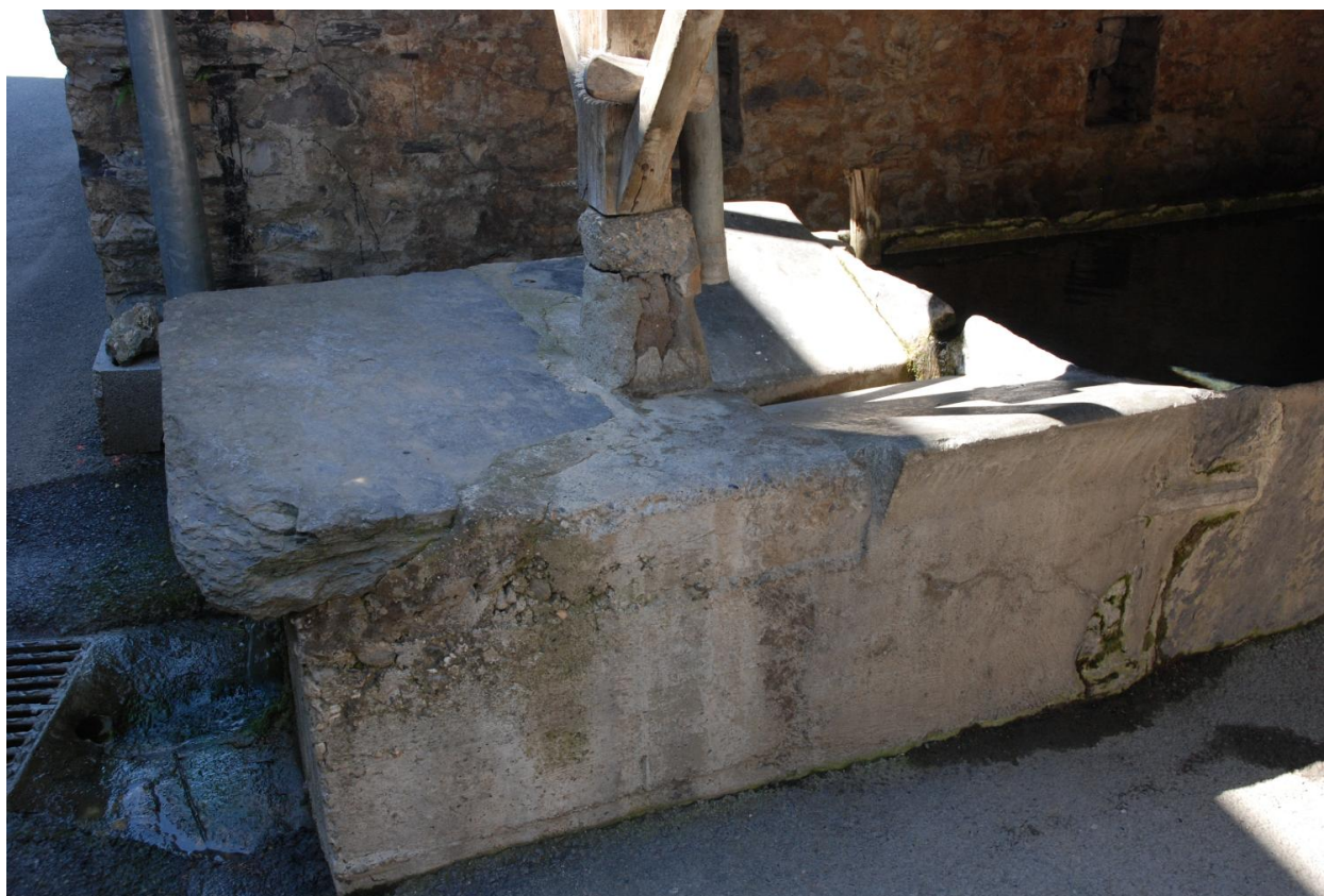
Détail de la partie aval : lavoir et banquette en lauze.
