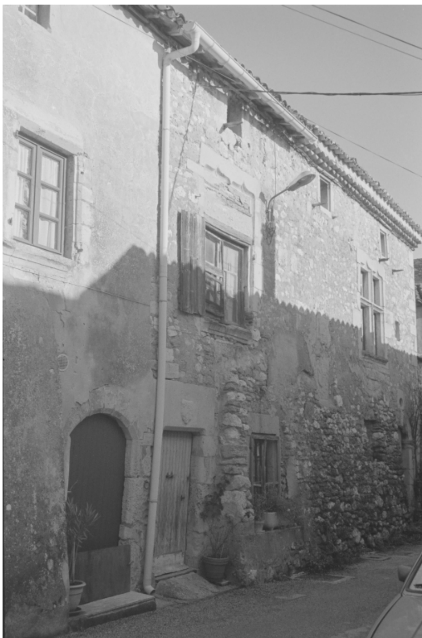
Vue d'ensemble de la façade sur rue, prise d'ouest en est.
