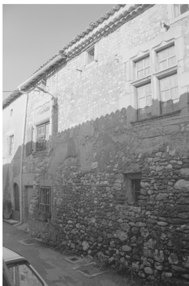
Vue partielle de la façade sur rue, percée de croisées à linteaux en accolade à l'étage, et présentant au centre des pierres ornées d'armoiries. Phot. Geneviève Jourdan IVR82_20042600007Z
