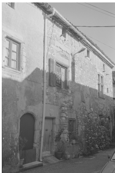
Vue d'ensemble de la façade sur rue, prise d'ouest en est. Phot. Geneviève Jourdan IVR82_20042600006Z
