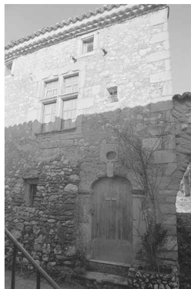
Vue partielle de la façade sur rue : porte d'entrée latérale, et, à droite, arc à chaperon couvrant l'entrée du passage donnant accès aux élévations latérale et postérieures. Phot. Geneviève Jourdan IVR82_20042600008Z
