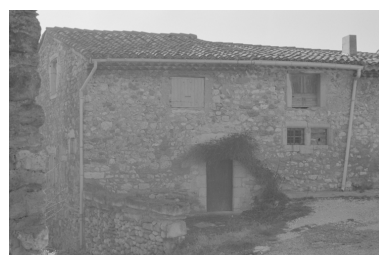
Elévation postérieure. Phot. Geneviève Jourdan IVR82_20042600010Z
