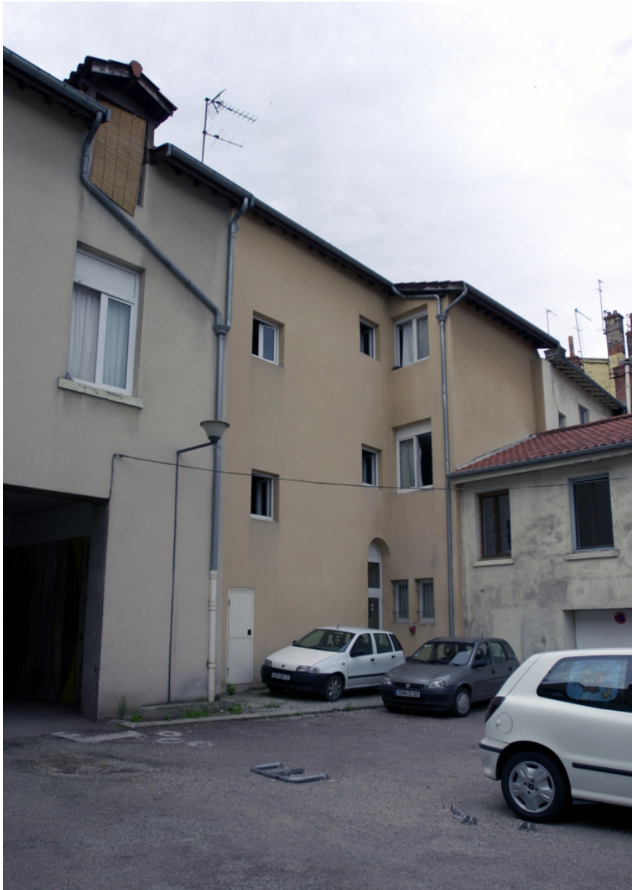
Elévation postérieure, vue partielle (à gauche de l'image)
