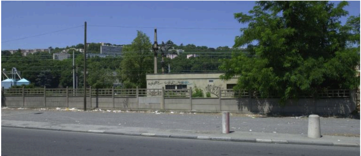
Vue générale depuis l'est
