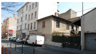
Maison démolie, au 41 rue Sébastien-Gryphe (vue prise en 2012) Phot. Catherine Guégan IVR82_20136900103NUCA
