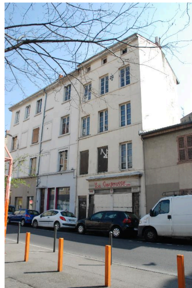
Immeuble démolit, au 39 rue Sébastien-Gryphe (vue prise en 2012) Phot. Catherine Guégan IVR82_20136900102NUCA
