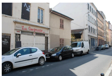
Bâtiments démolis (état 2012) Phot. Catherine Guégan IVR82_20136900106NUCA
