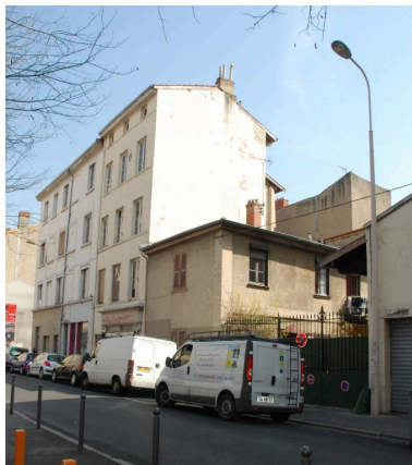
Immeuble et maison démolis (vue prise en 2012) Phot. Catherine Guégan IVR82_20136900101NUCA
