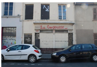
Local de la coopérative d'habitants "La Gargousse" (état 2012) Phot. Catherine Guégan IVR82_20136900105NUCA
