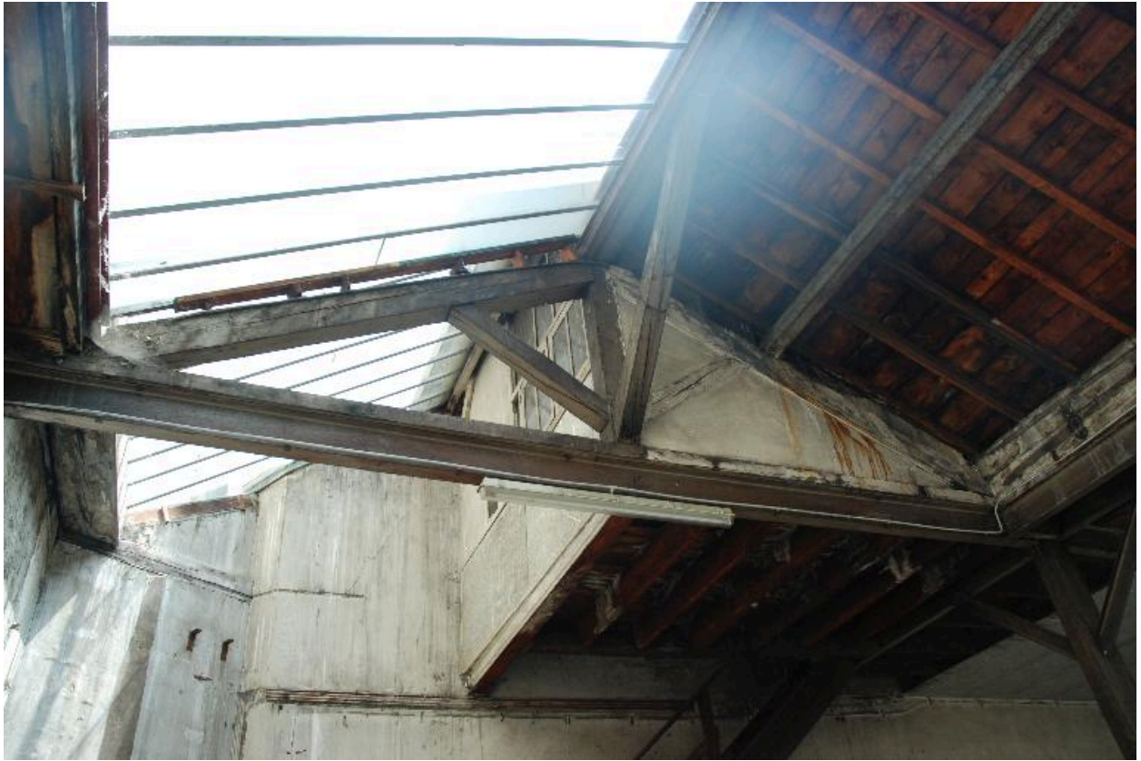
Vue intérieure : accès aux bureaux en partie supérieure.
