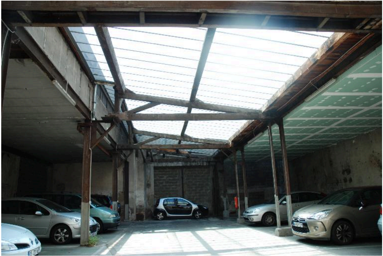
Vue générale intérieure, en direction du 5 rue Passet.
