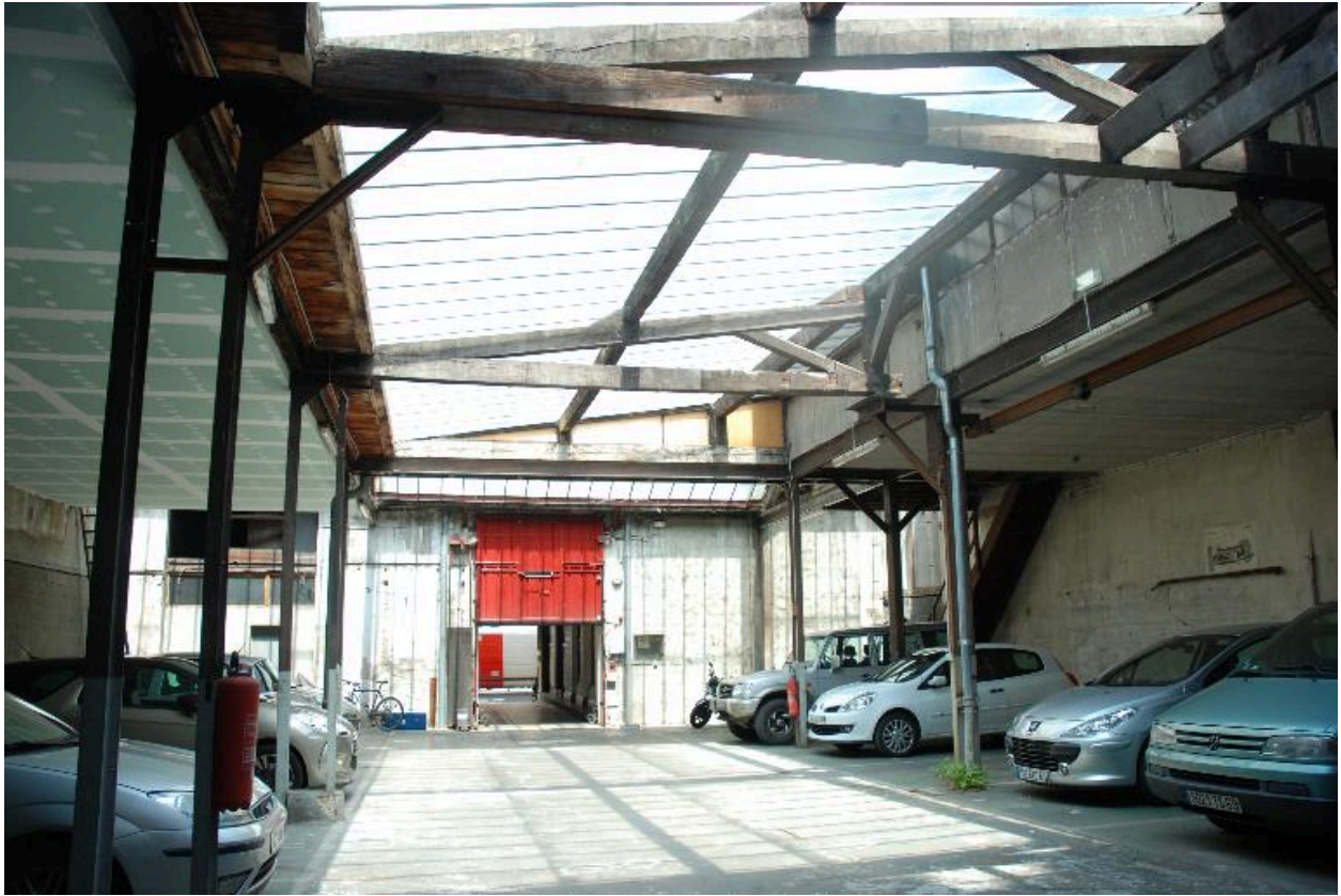
Vue générale intérieure, en direction du 6 rue Basse-Combalot.
