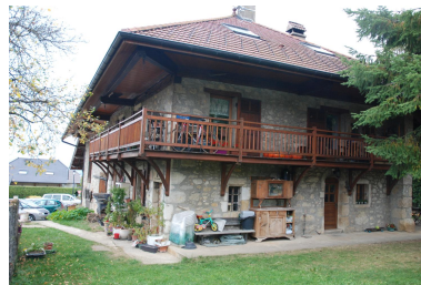
Vue de l'habitation depuis le sud. Phot. Caroline Guibaud IVR84_20207402719NUCA
