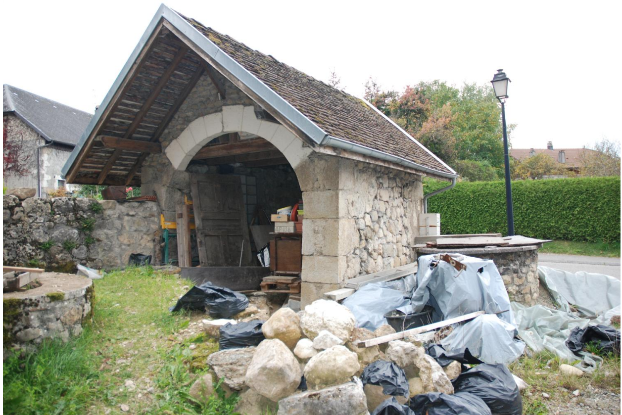
Vue du four à pain.
