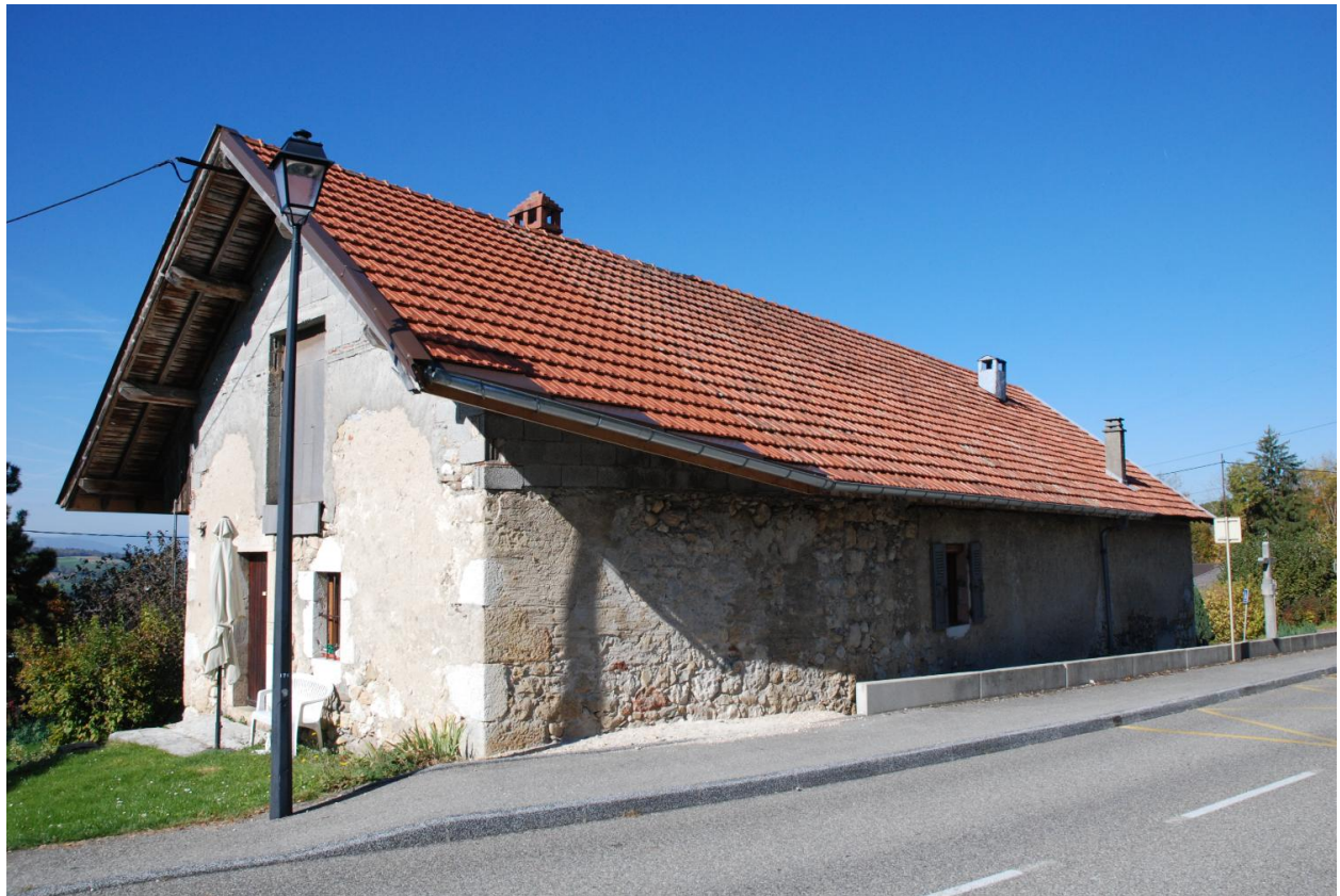
Vue d'ensemble côté route.
