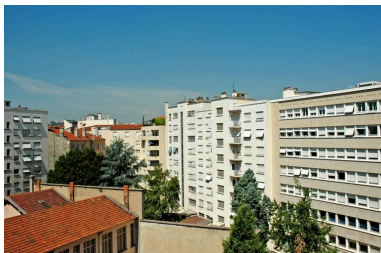
Elévation postérieure, vue générale depuis le sud-est Phot. Maryannick Chalabi IVR82_20066903073NUCA
