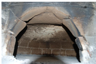
Vue intérieure de la voûte du four Phot. Thierry Monnet IVR84_20187301214NUCA
