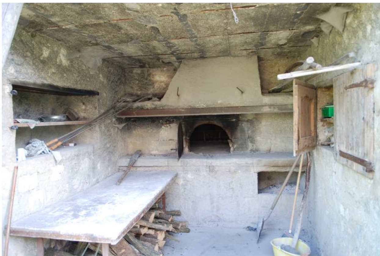
Vue intérieure du fournil.
