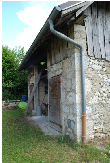
Vue d'ensemble. Phot. Thierry Monnet IVR84_20187301212NUCA
