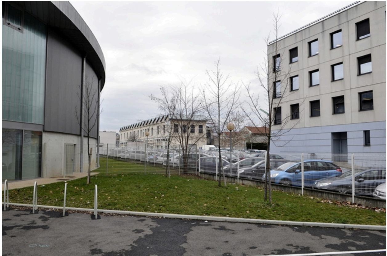
Vue générale est (avenue Paul Santy)
