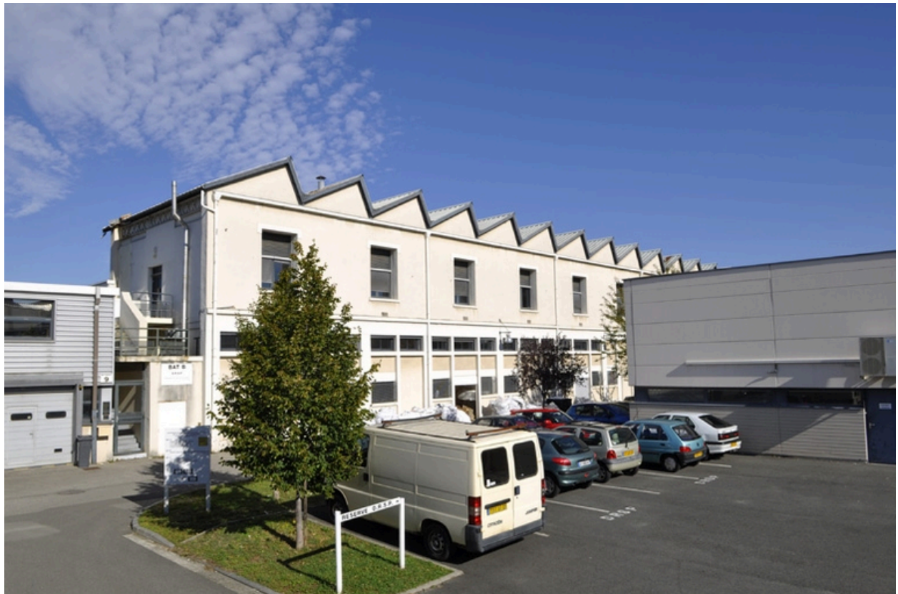
Bâtiment de l'ancienne usine Vidéocolor
