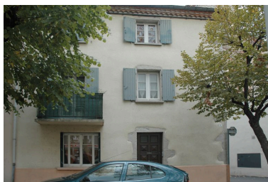
Elévation sur le boulevard Lachèze. Phot. Simone Hartmann-Nussbaum IVR82_20114201364NUCA
