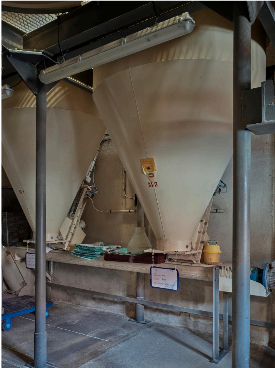
Rez-de-chaussée, mélangeuses de blés.
