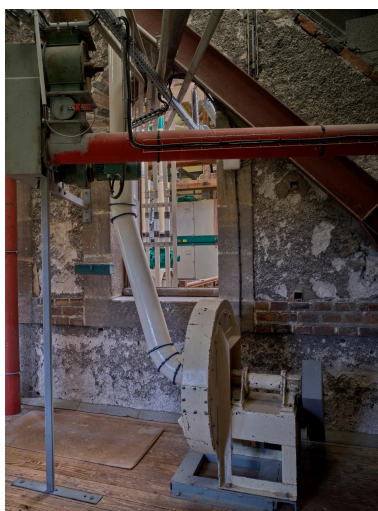
Premier étage, vue du mur et d'une baie de l'ancien bâtiment. Phot. Christian Parisey IVR84_20240300467NUC4A
