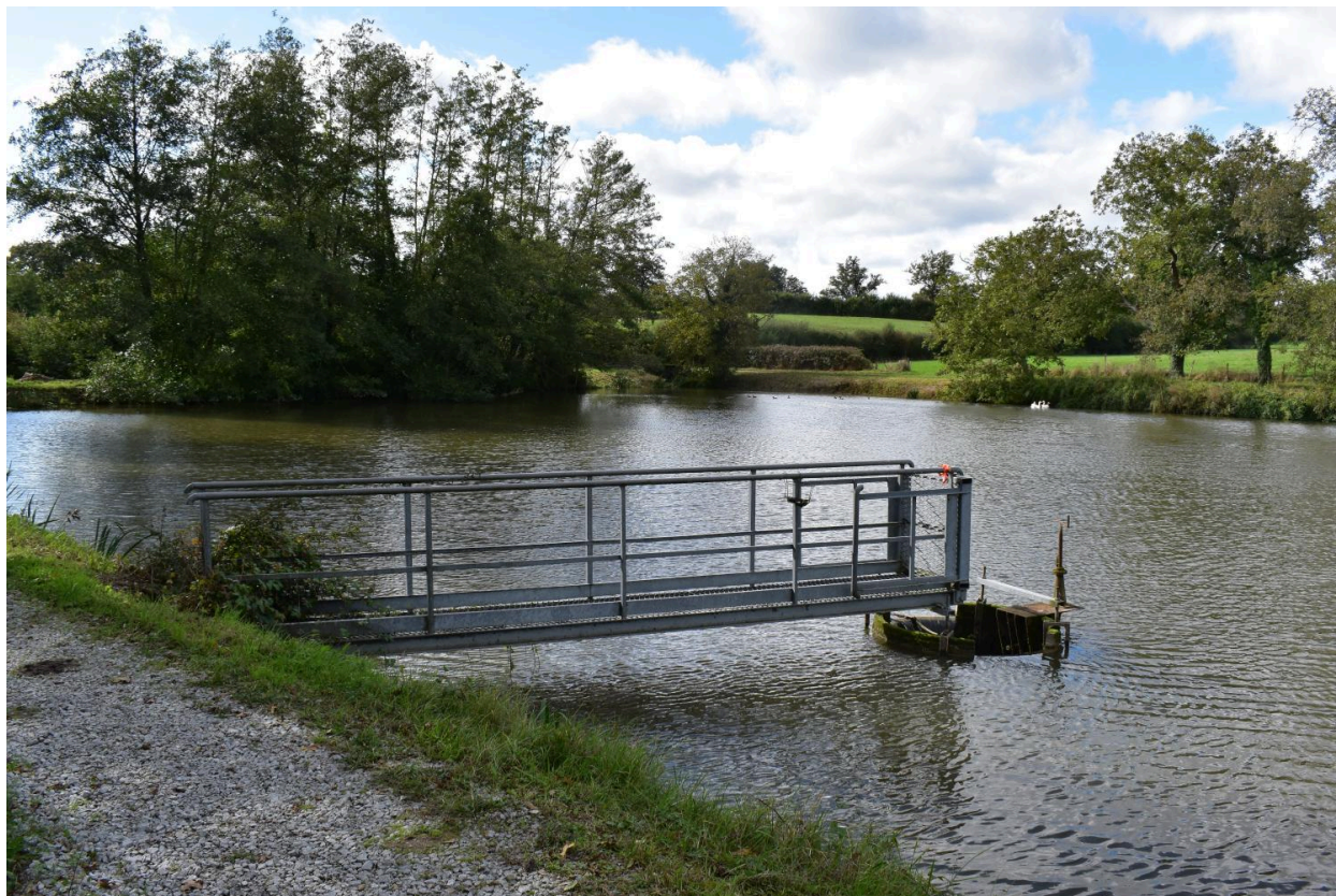
Étang : vue de la passerelle et du moine de vidange.
