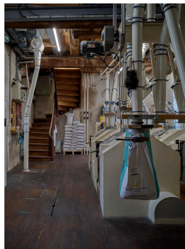
Rez-de-chaussée : vue de l'escalier d'accès au premier étage au second plan. Phot. Christian Parisey IVR84_20240300464NUC4A
