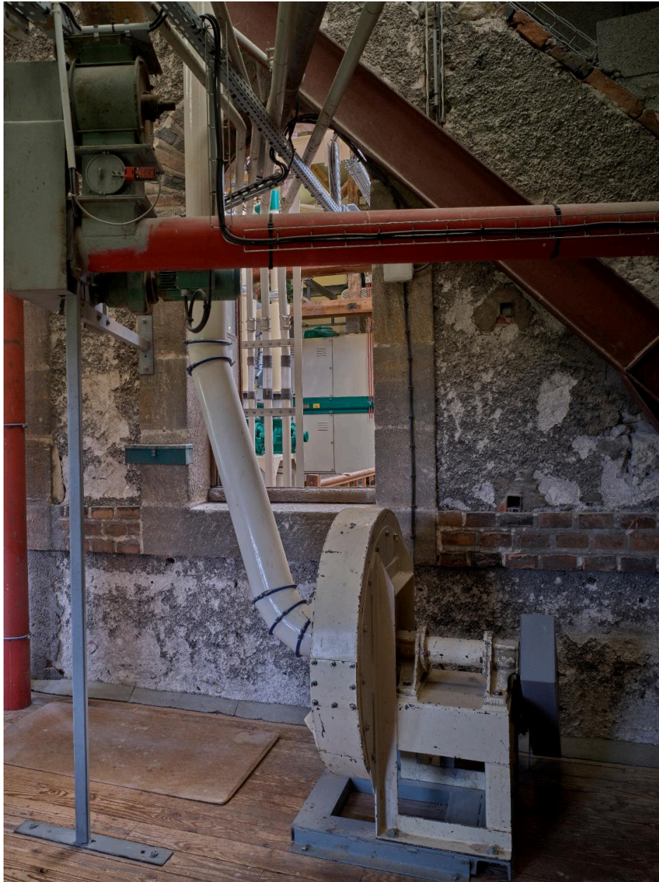
Premier étage, vue du mur et d'une baie de l'ancien bâtiment.
