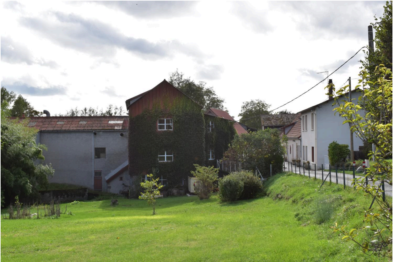
Vue du moulin au nord.
