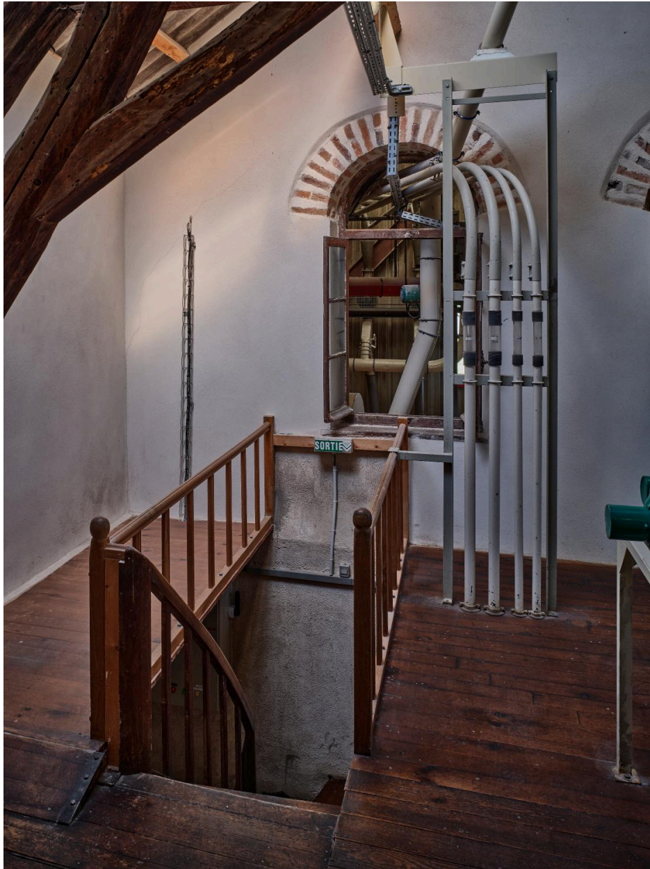
Premier étage, vue des baies de l'ancien bâtiment.
