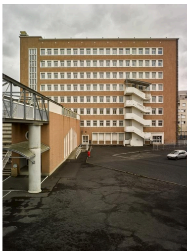
Depuis la cour vers l'est : façade du bâtiment 5. La cage d'escalier ouverte accolée à la façade est un ajout au projet initial mais son dessin est à rapprocher d'escaliers du lycée Ambroise-Brugière (1962-1964), du même architecte et à Clermont-Ferrand. Phot. Christian Parisey IVR84_20196300060NUC4A
