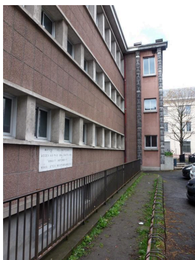
Bâtiment des sciences naturelles : au-devant de l'avant-corps correspondant à la cage d'escalier, une greffe en avancée correspond à l'ajout d'une cage d'ascenseur, les baies éclairant un dégagement vers l'ascenseur. Phot. Bénédicte Renaud-Morand IVR84_20196300107NUCA
