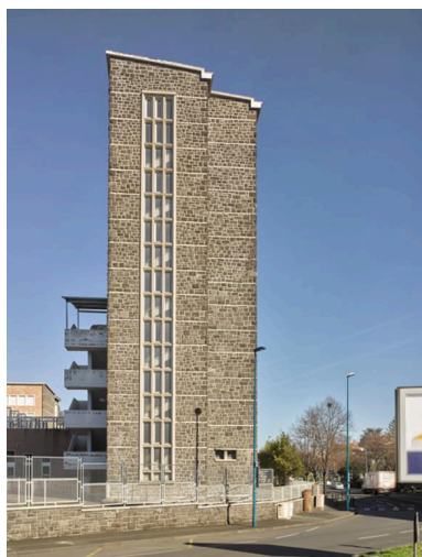
Depuis l'angle de la rue de l'Oradou et la rue d'Amboise. Phot. Christian Parisey IVR84_20196300020NUC4A
