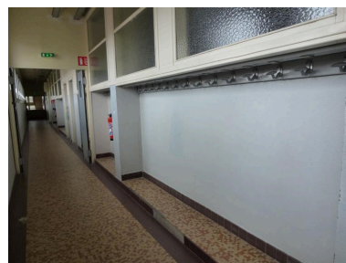
Bâtiment des classes préparatoires, couloir avec porte-manteaux. À l'origine il s'agissait du bâtiment du Petit lycée, ce dont témoigne la hauteur des porte-manteaux. Il était relié au "petit gymnase" par un préau couvert, préau qui ne semble pas avoir été réalisé.
