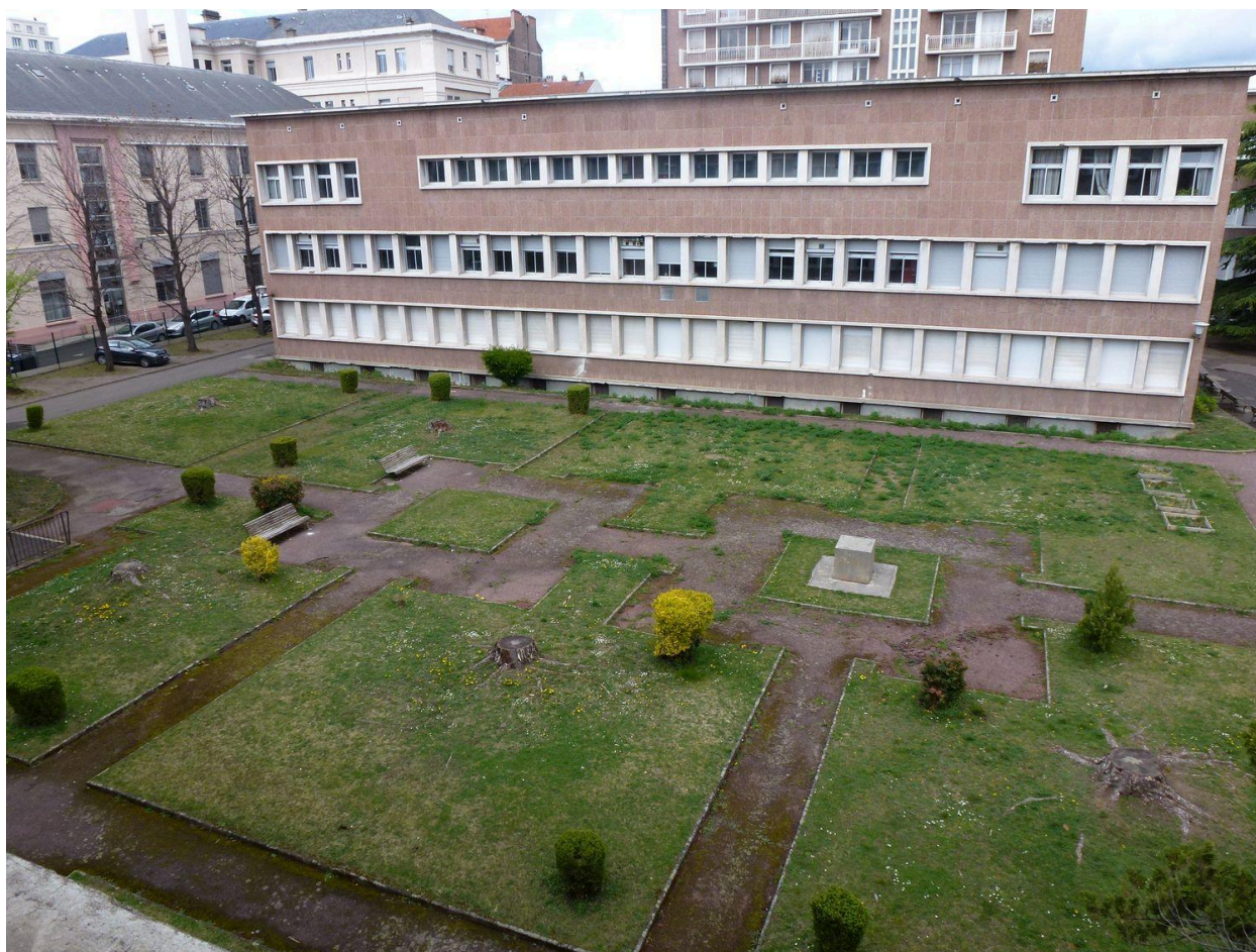
Vue du parterre compartimenté, depuis le bâtiment des sciences physiques vers le bâtiment des sciences naturelles, dont le dessin est de Georges Noël. Voir plan d'ensemble "projet d'aménagements des extérieurs" du 2 novembre 1958.
