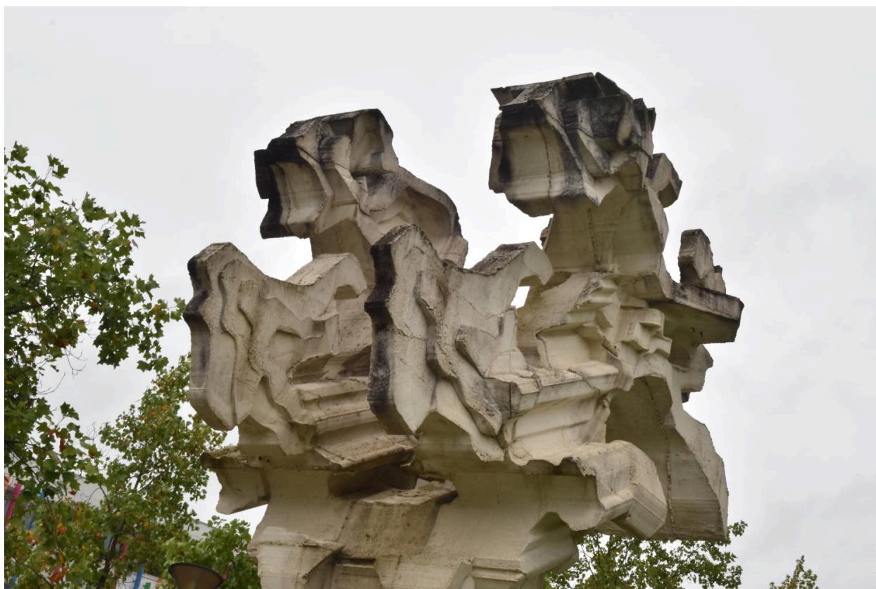
Détail de la partie supérieure ; encrassement localisé
