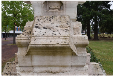
Détail des altérations : lichens ? Phot. Catherine Guégan IVR84_20240300378NUCA
