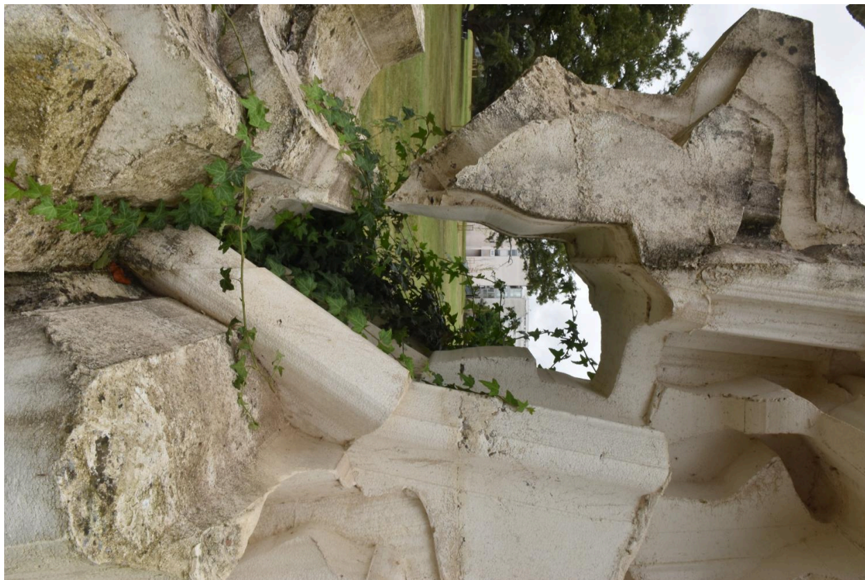
Détail des altérations : envahissement par la végétation
