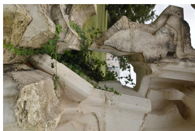
Détail des altérations : envahissement par la végétation Phot. Catherine Guégan IVR84_20240300374NUCA
