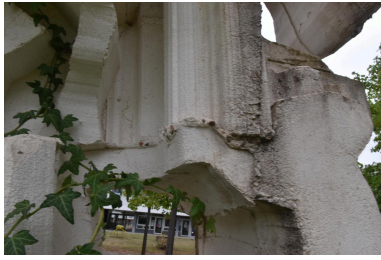
Détail des joints en ciment avec présence de graviers Phot. Catherine Guégan IVR84_20240300377NUCA
