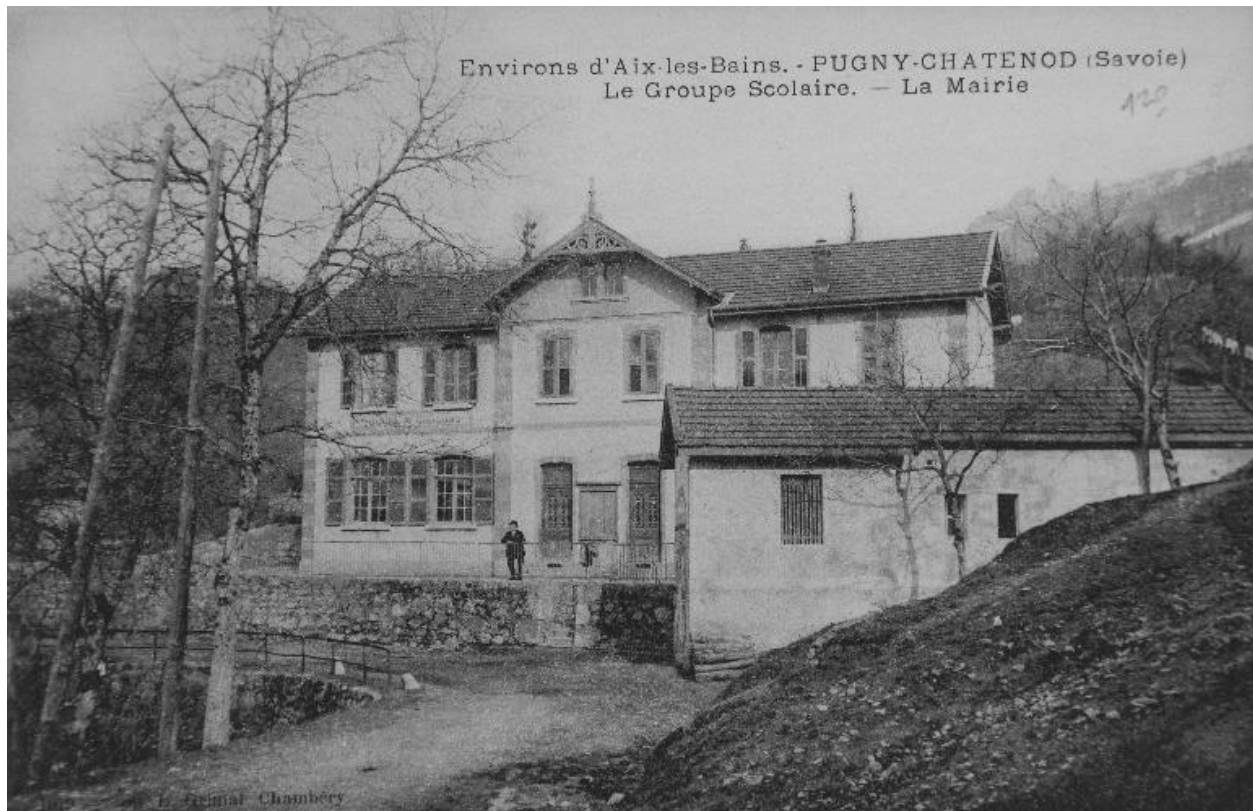
Environs d'Aix-les-Bains. – PUGNY-CHATENOD (Savoie) Le Groupe Scolaire. – La Mairie 1019. Carte postale 1er quart 20e siècle (AP Podevin)
