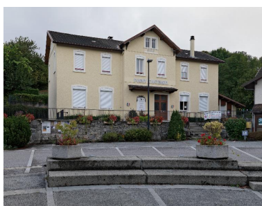
Vue d'ensemble de l'ancienne mairie-école.
