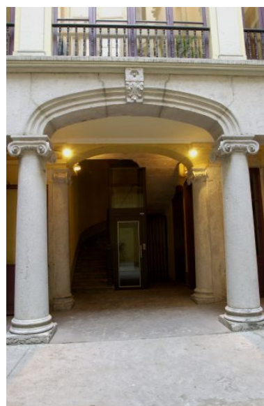
Corps de l'escalier, partie centrale du rez-de-chaussée Phot. Bernard Ducouret IVR82_20046900417NUCA
