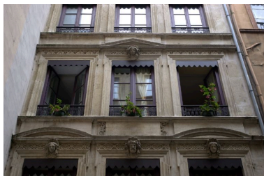
Façade rue Longue, détail des fenêtres des 1er et 2e étages Phot. Bernard Ducouret IVR82_20046900414NUCA
