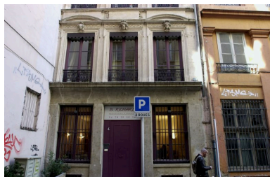
Façade rue Longue, rez- de-chaussée et 1er étage Phot. Phot. Inv. D. Chevallier IVR82_20046900413NUCA
