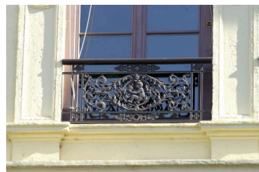
Façade principale place d'Albon, 3e niveau, détail de l'appui de la fenêtre de gauche Phot. Bernard Ducouret IVR82_20046900409NUCA
