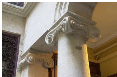
Corps de l'escalier, détail des chapiteaux du rez-de-chaussée Phot. Phot. Inv. D. Chevallier IVR82_20046900418NUCA
