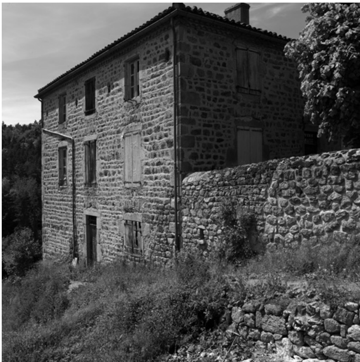
Vue d'ensemble de la façade est.
