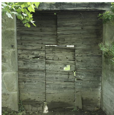
Vue des vantaux du portail. Phot. Didier Gourbin IVR82_20054201927NUCA
