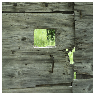
Détail des vantaux du portail. Phot. Didier Gourbin IVR82_20054201926NUCA
