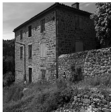
Vue d'ensemble de la façade est. Phot. Didier Gourbin IVR82_20054201946NUC
