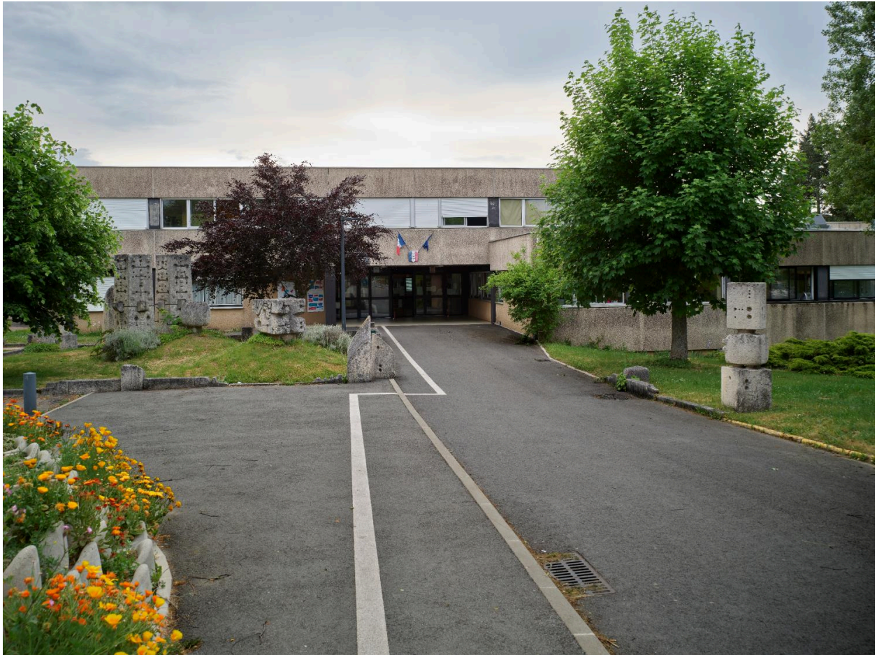
Lycée professionnel Desaix, 1981-1983 (Puy-de-Dôme) : entrée du lycée (externat) et oeuvre du 1% artistique de Pierre Marion. Une opération d'urgence a été réalisée avant restructuration des bâtiments et démolition de l'internat
