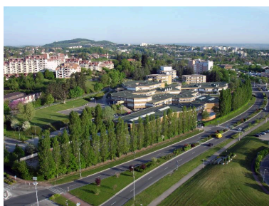
Lycée Léonard de Vinci, Villefontaine, 1976-1981 (Isère) : vue aérienne (coll. D. Gomard) Phot. Didier Gomard IVR84_20173800474NUCA
