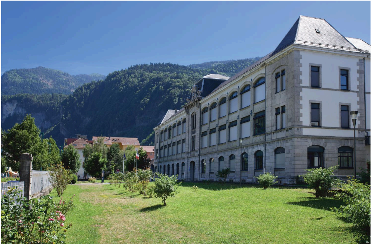
Lycée Charles-Poncet à Cluses, 1880-1885 (Haute-Savoie), ancienne école nationale professionnelle d'horlogerie
