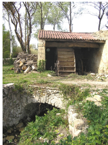
Vue de la roue et du bief. Phot. S. Joly IVR82_20092600020NUCA
