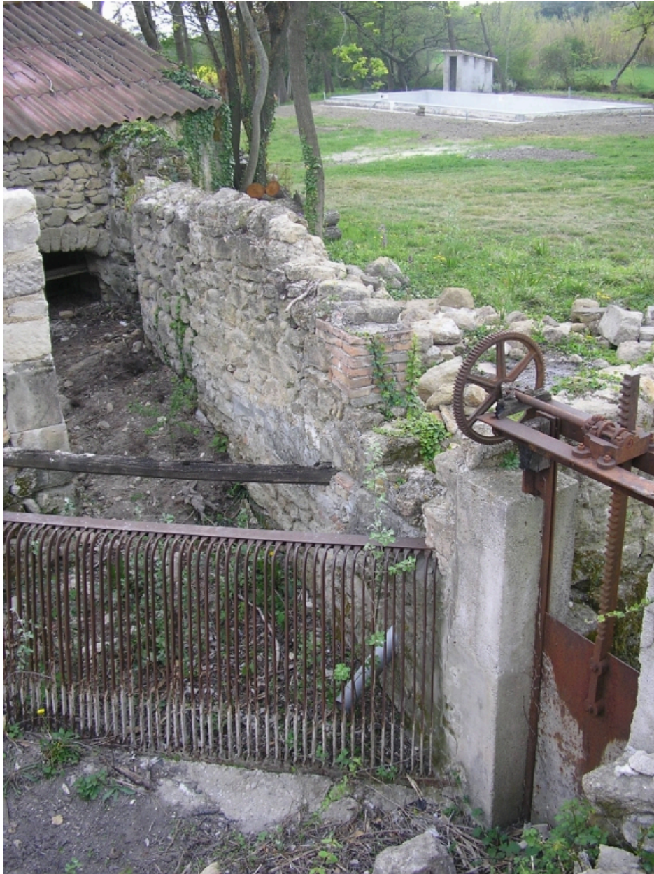
Vue du canal de dérivation venant de l'Aulière.
