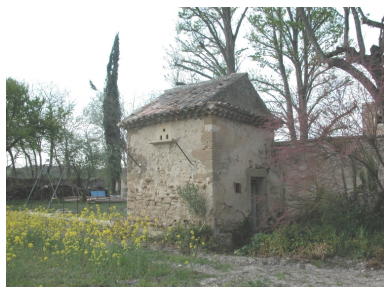
Vue du pavillon d'entrée orienté à l'est. Phot. Geneviève Jourdan IVR82_20092600018NUCA
