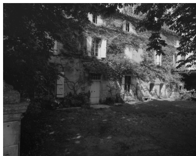
Elévation principale du logis à Moutière (B2 590). Phot. Alain Franchella IVR82_19972600250X
