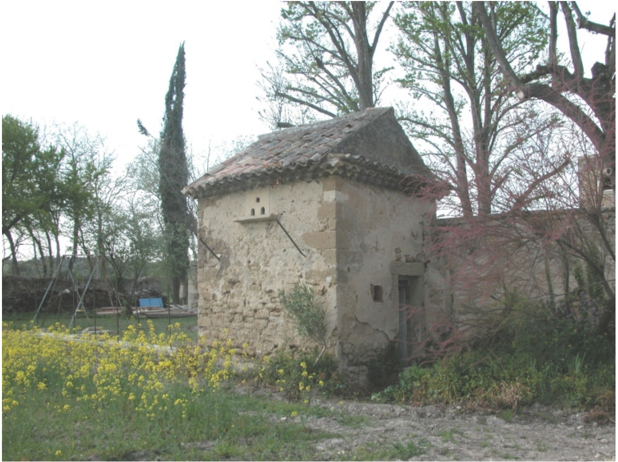
Vue du pavillon d'entrée orienté à l'est.
