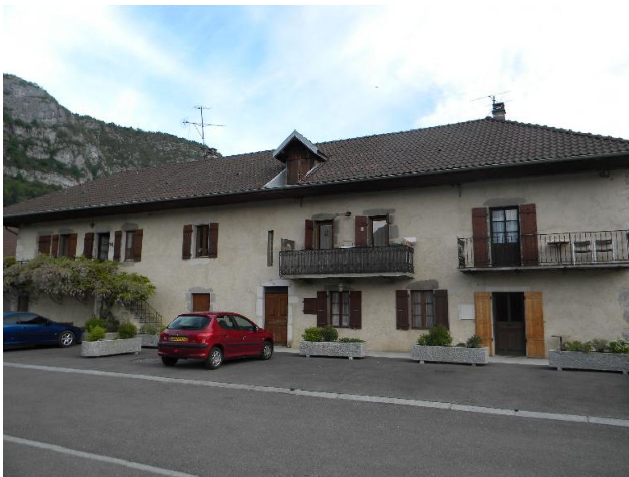
Vue de la façade sud.
