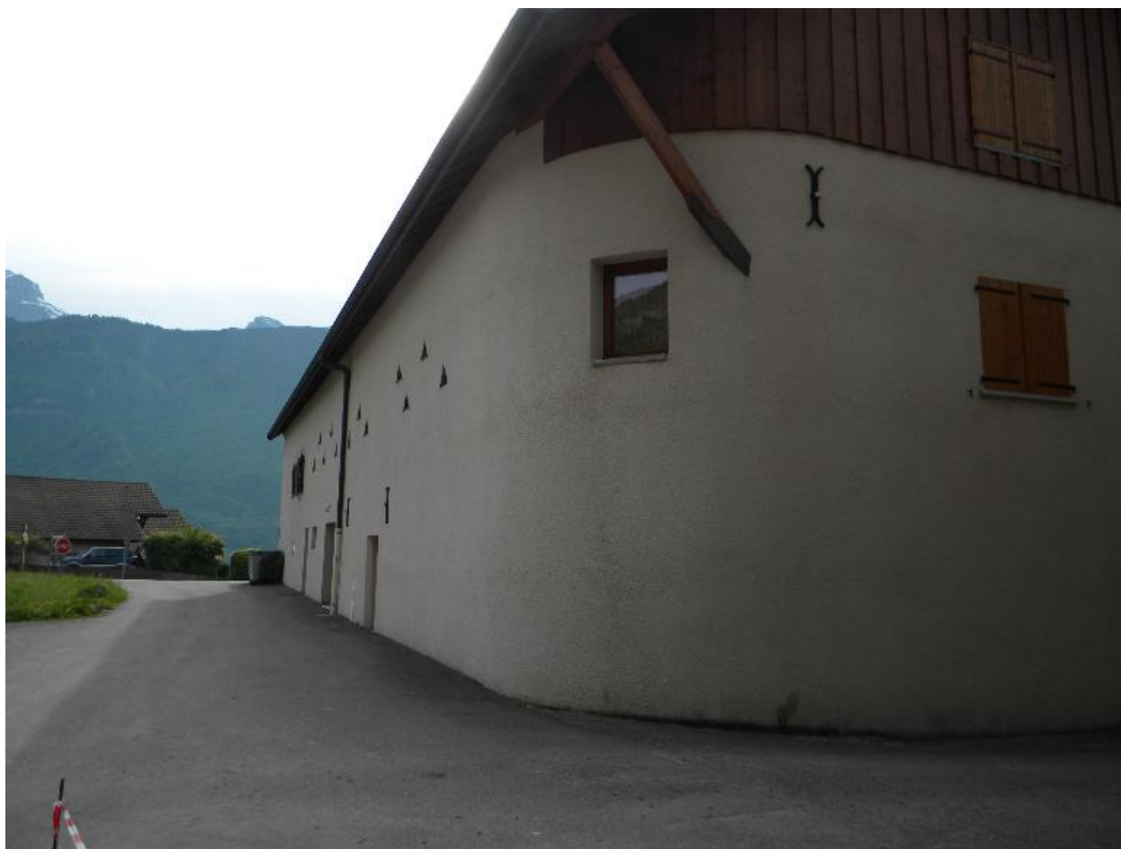
Vue de la façade extérieure de l'aile nord depuis l'ouest.
