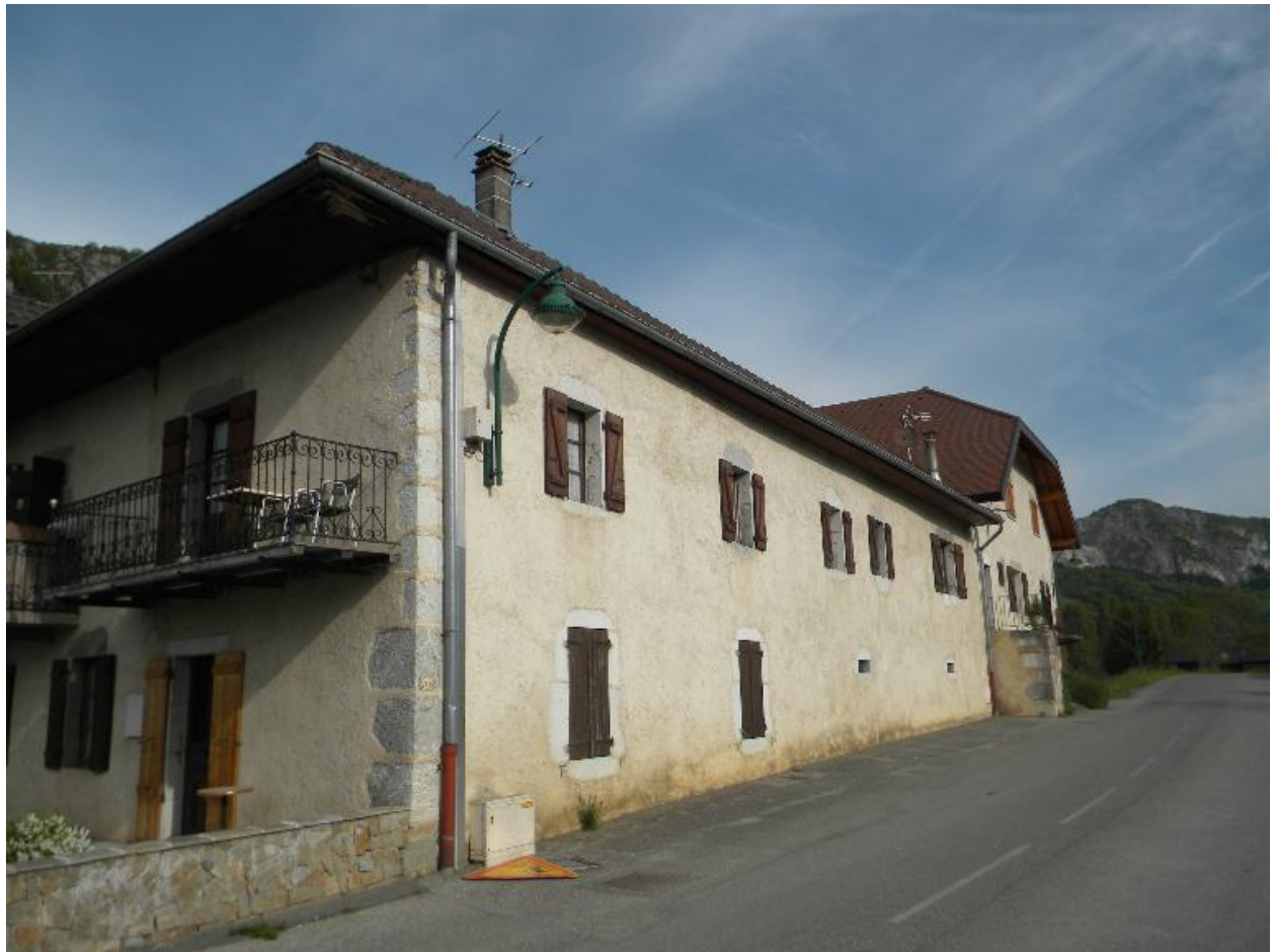
Vue de la façade est.
