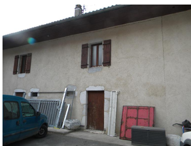
Vue de la façade de l'aile sud depuis la cour. Phot. Jérôme Daviet IVR82_20147400131NUCA
