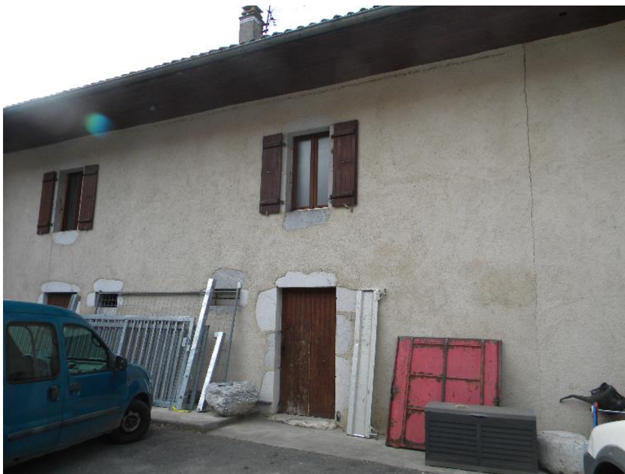
Vue de la façade de l'aile sud depuis la cour.
