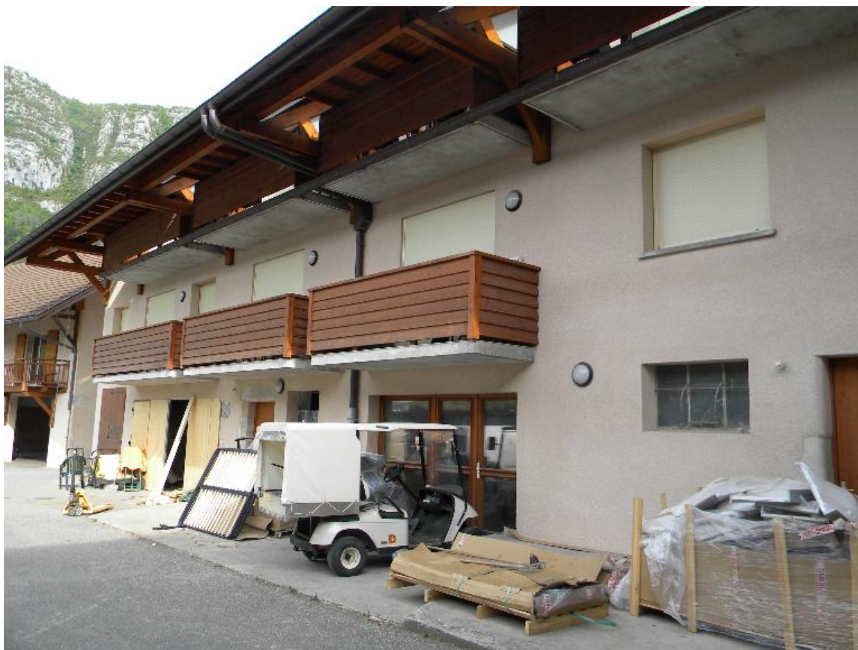
Vue de la façade intérieure de l'aile nord depuis la cour
