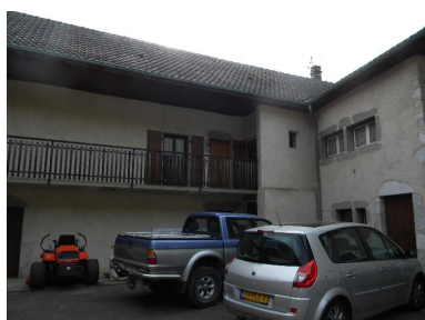
Vue de l'angle nord-est depuis la cour. Phot. Jérôme Daviet IVR82_20147400133NUCA
