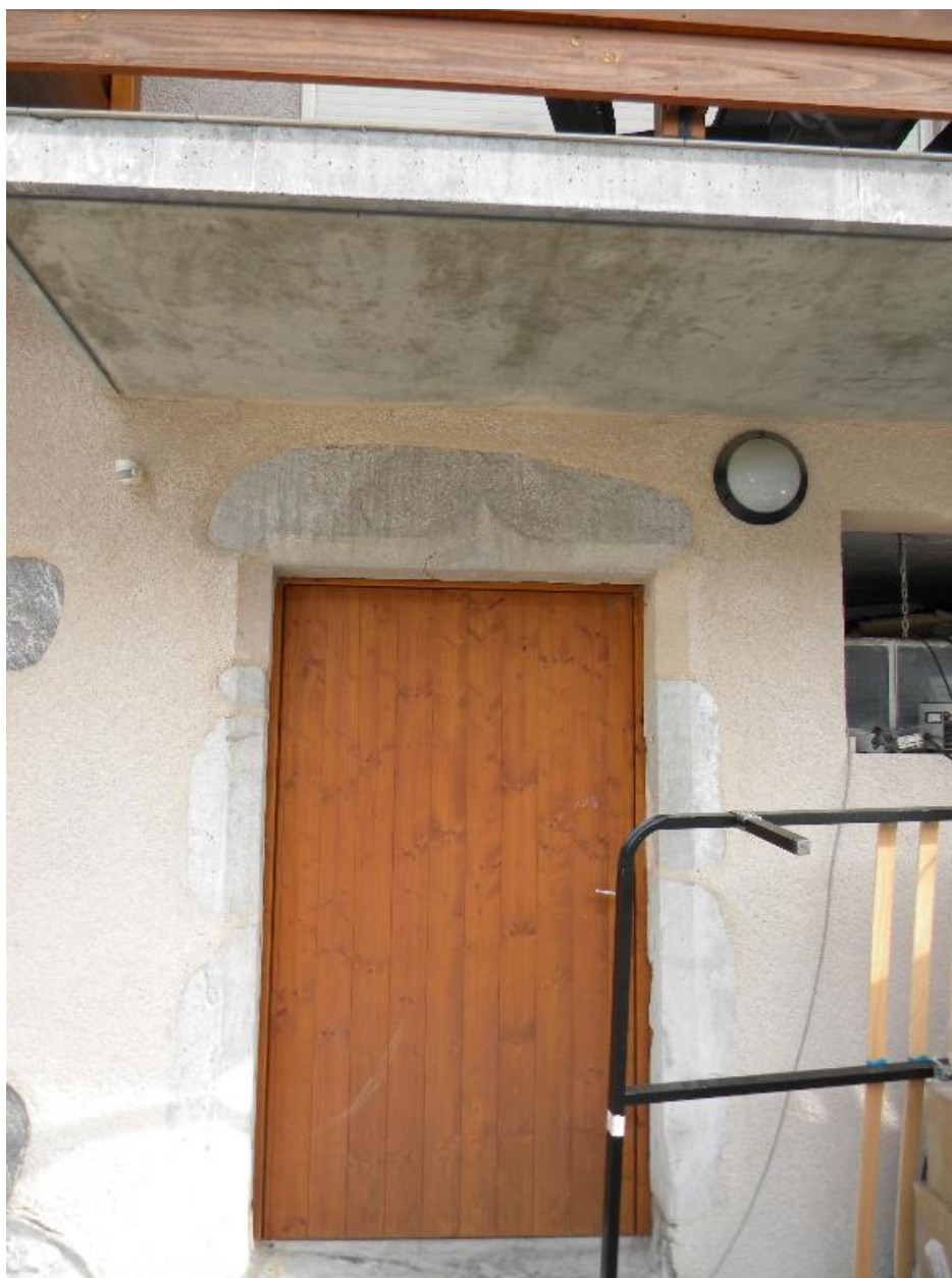
Vue d'un encadrement de porte avec accolade sur la façade intérieure de l'aile nord.
