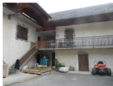
Vue de l'angle sud est depuis la cour. Phot. Jérôme Daviet IVR82_20147400132NUCA
