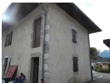
Vue de trois quarts de l'aile sud depuis la cour intérieure. Phot. Jérôme Daviet IVR82_20147400130NUCA
