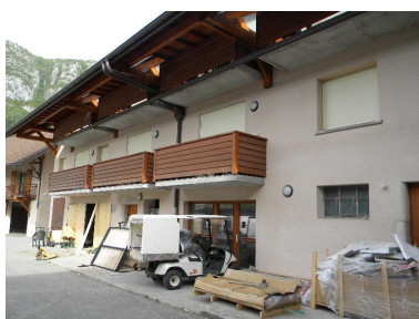
Vue de la façade intérieure de l'aile nord depuis la cour Phot. Jérôme Daviet IVR82_20147400134NUCA
