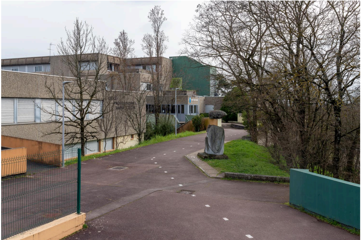
Vue générale, dans son environnement.
