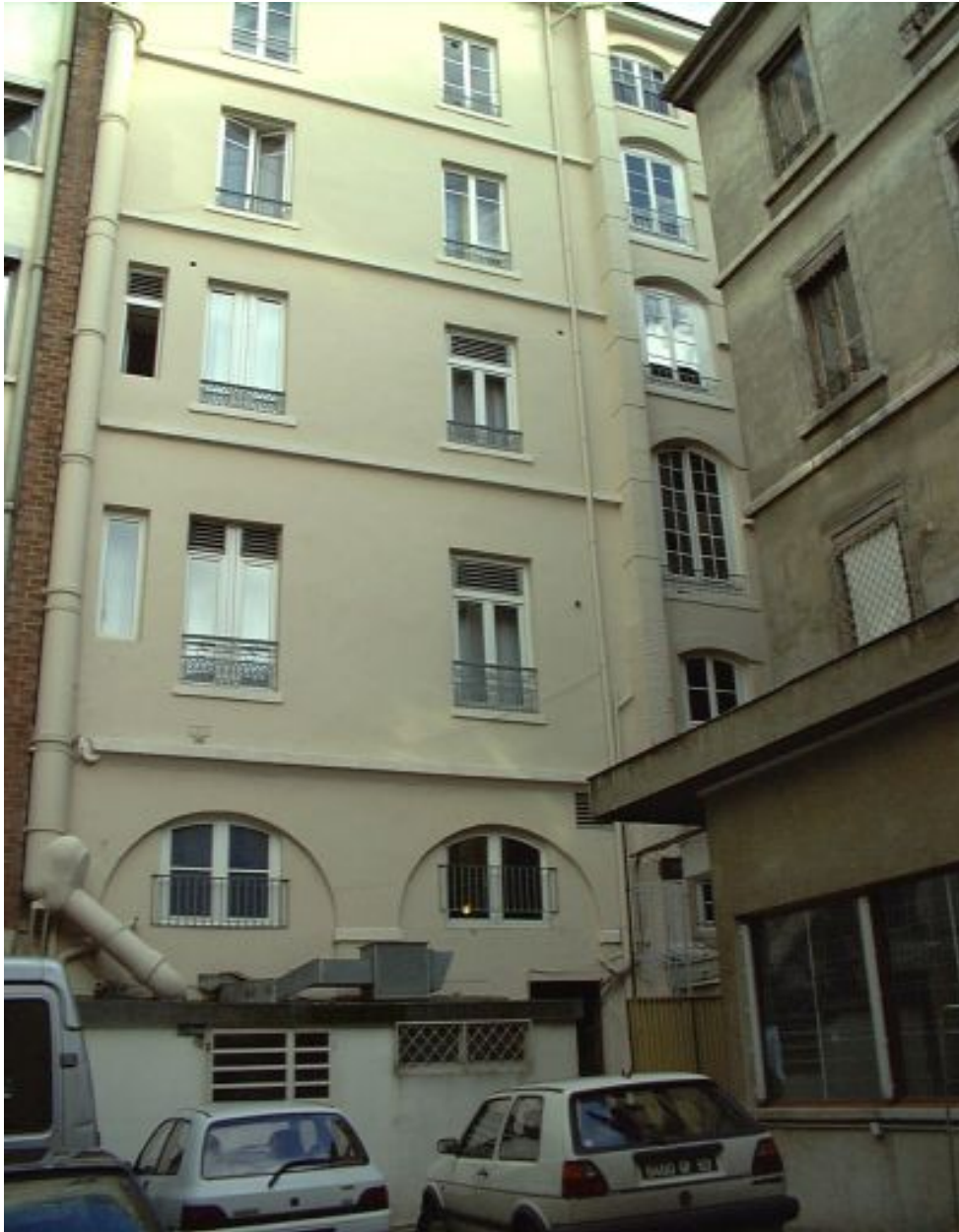
Elévation sud, sur la cour
