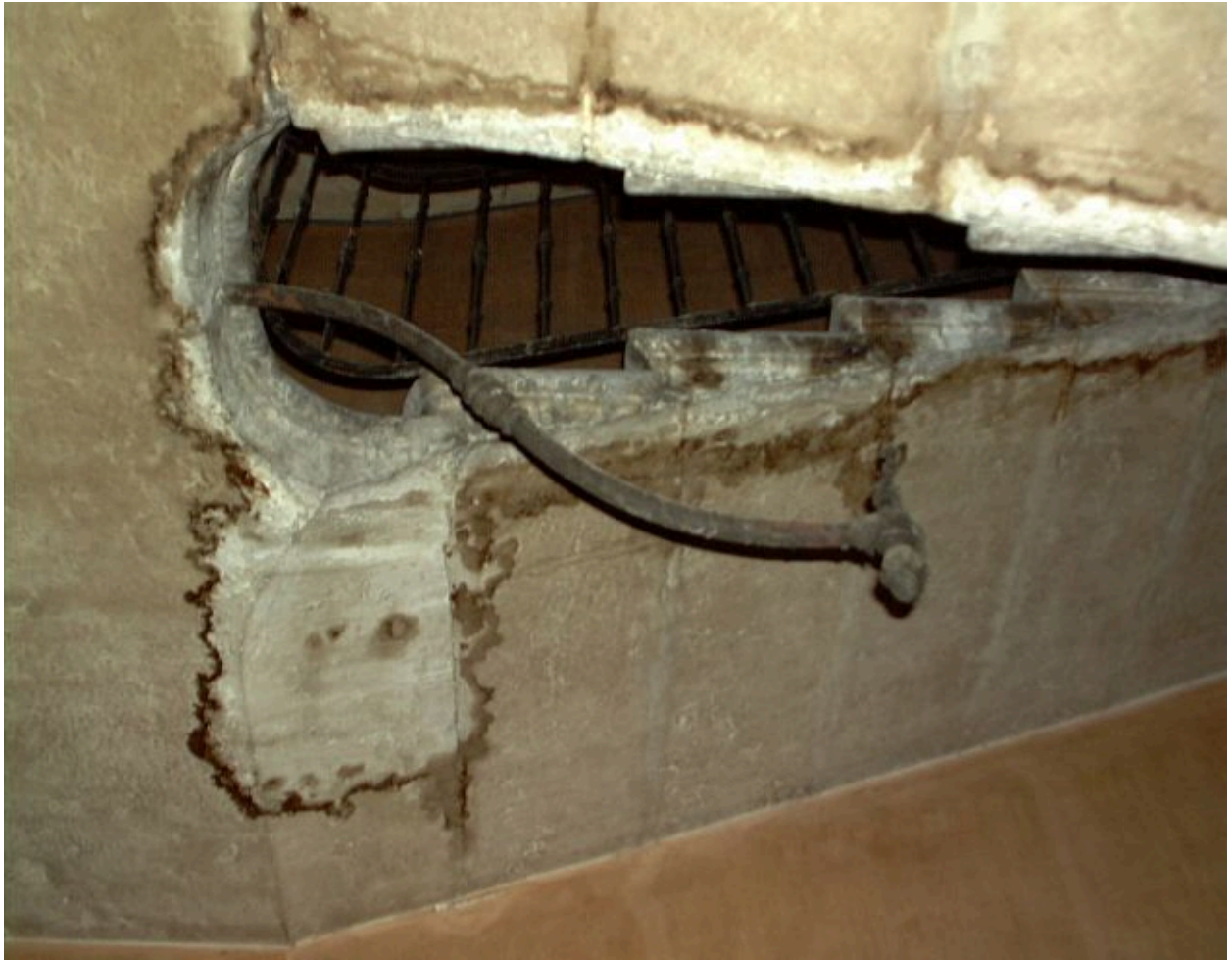
Détail de la potence du bec de gaz éclairant autrefois l'escalier
