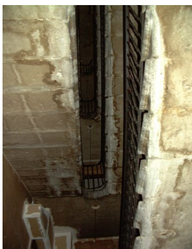
Vue de l'escalier Phot. Bernard Ducouret IVR82_20006900675NUCA
