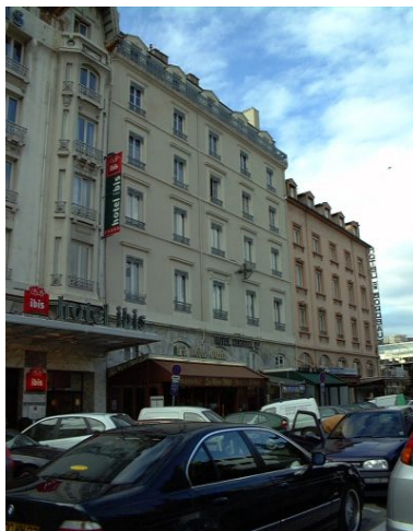
Elévation cours de Verdun Phot. Bernard Ducouret IVR82_20006900673NUCA
