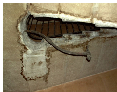
Détail de la potence du bec de gaz éclairant autrefois l'escalier Phot. Bernard Ducouret IVR82_20006900676NUCA
