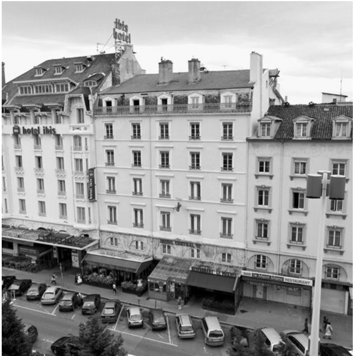
Vue de situation depuis les jardins suspendus du centre d'échanges côté Rhône
