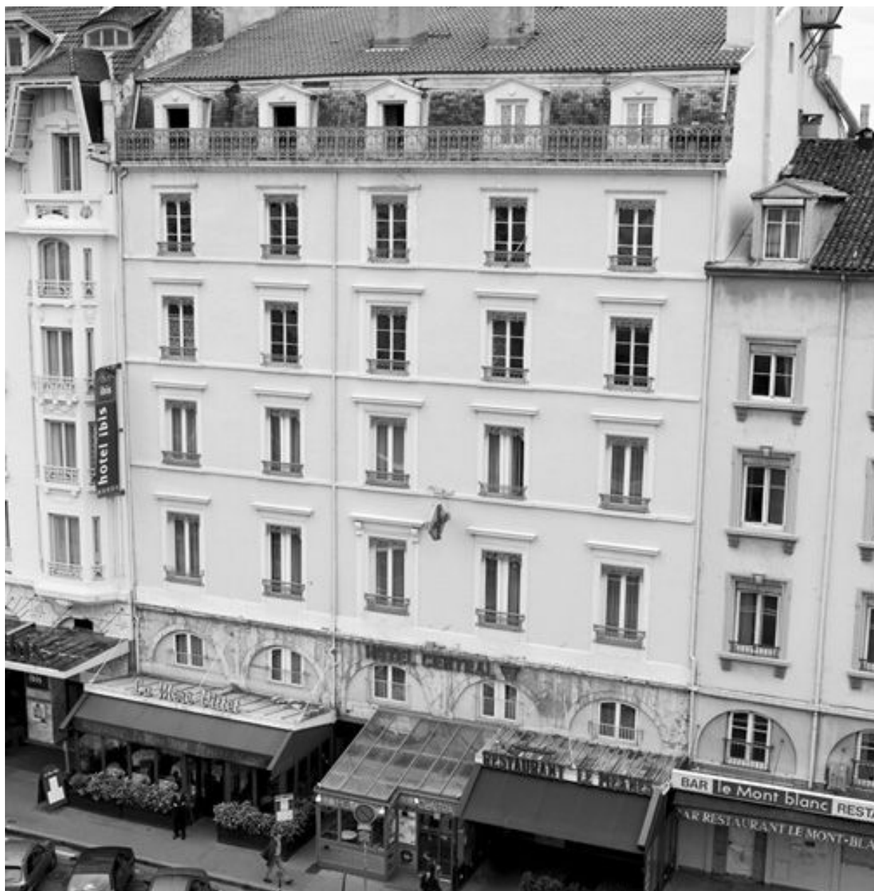
Elévation antérieure depuis les jardins suspendus du centre d'échanges côté Rhône
