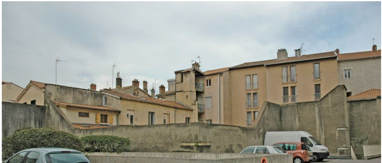
Aperçu de la partie supérieure du mur nord depuis le nord- est
