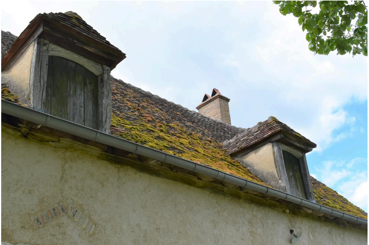
Détail des lucarne en capucine éclairant les combles à l'est.
