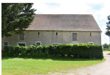
Vue générale de la grange sud. Phot. Maryse Durin-Tercelin IVR84_20250300581NUC4A
