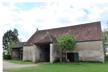
Vue générale de la grange à auvent. Phot. Maryse Durin-Tercelin IVR84_20250300576NUC4A
