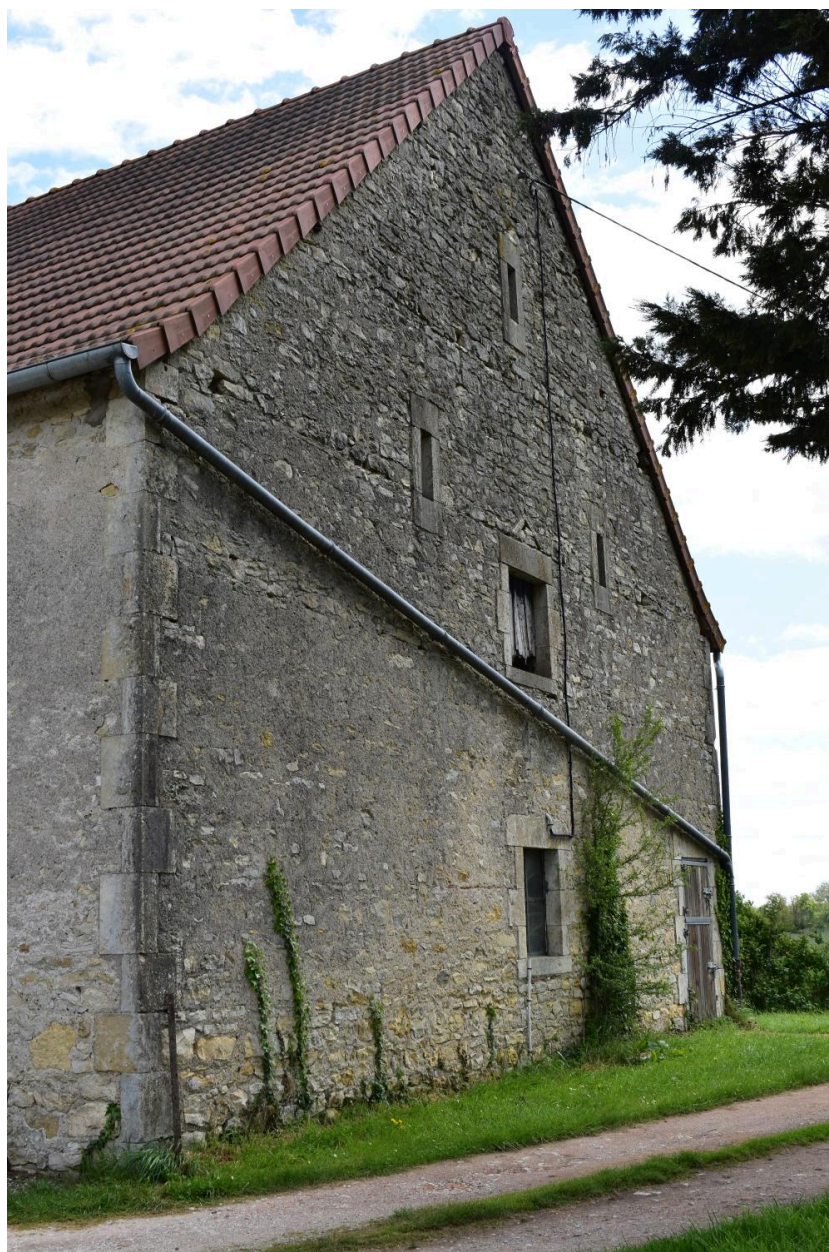
Vue du pignon occidental de la grange sud.
