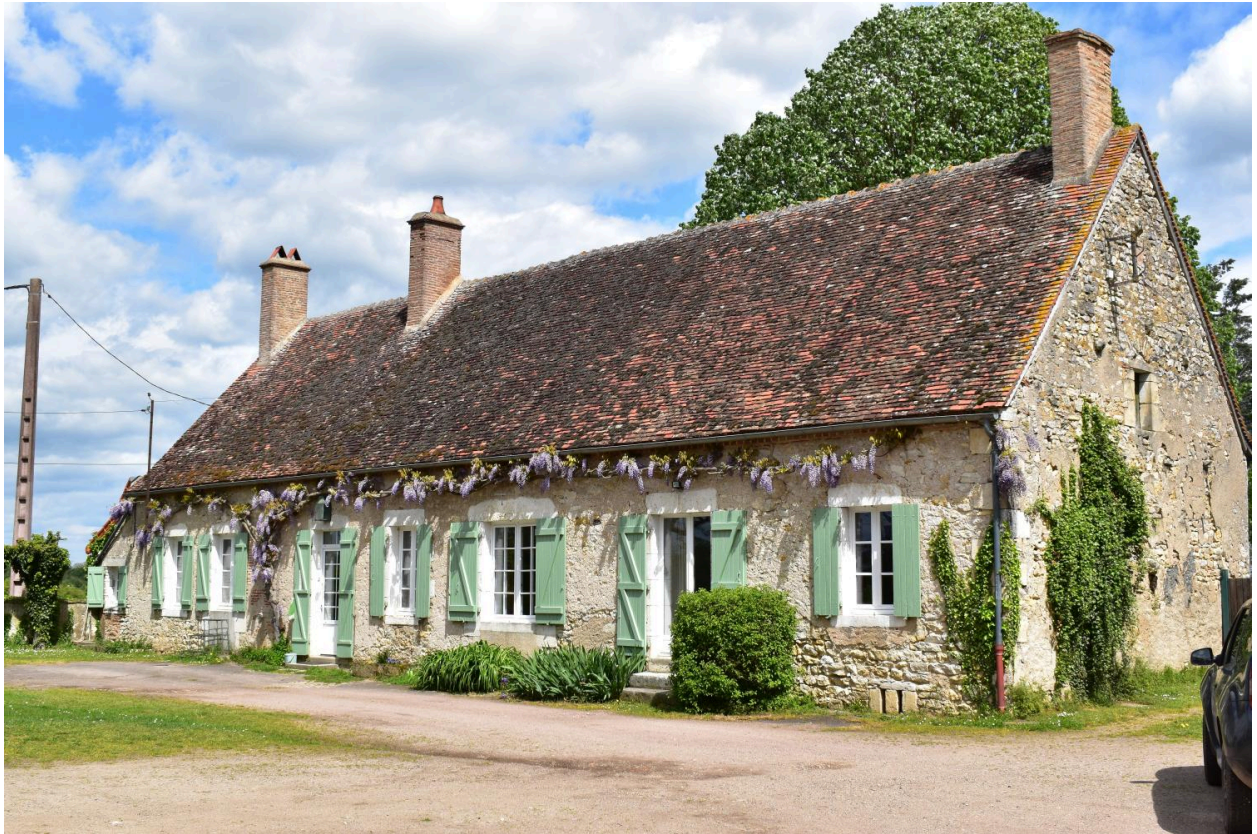
Vue de la façade occidentale de la maison d'habitation.
