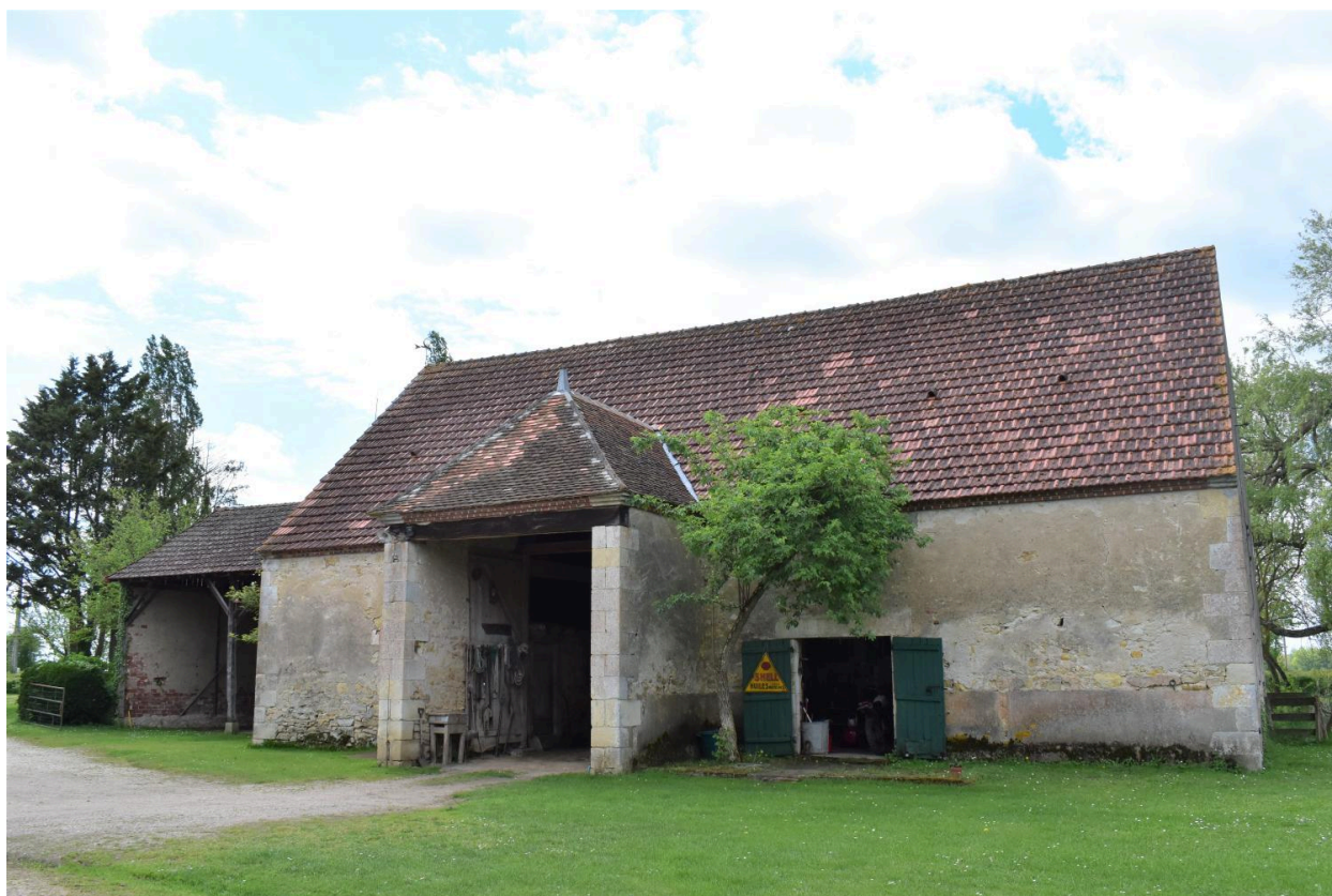
Vue générale de la grange à auvent.
