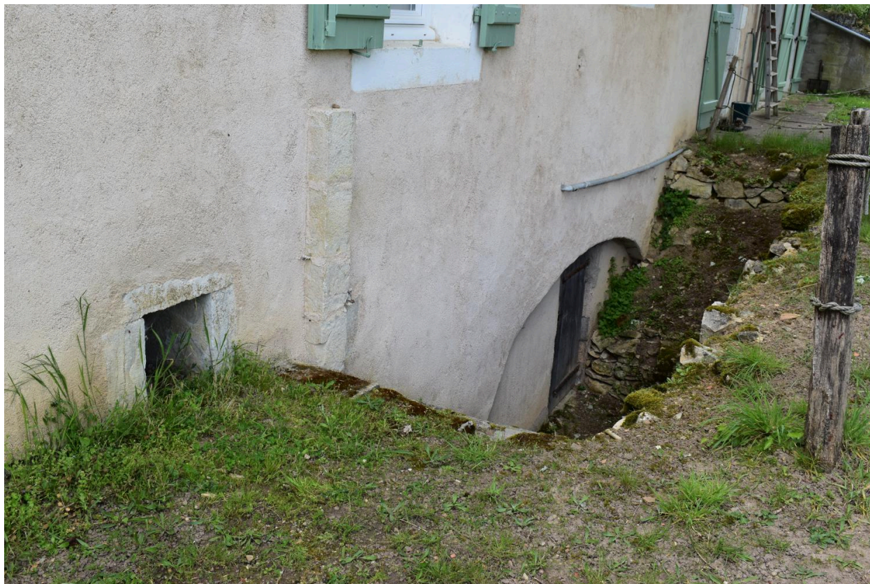
Détail de l'accès à la cave.
