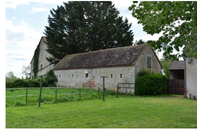
Vue postérieure de la porcherie. Phot. Maryse Durin-Tercelin IVR84_20250300588NUC4A
