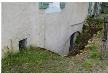
Détail de l'accès à la cave. Phot. Maryse Durin-Tercelin IVR84_20250300589NUC4A
