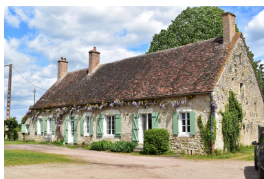
Vue de la façade occidentale de la maison d'habitation. Phot. Maryse Durin-Tercelin IVR84_20250300585NUC4A
