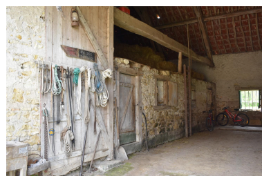
Intérieur du "battan" de la grange à auvent Phot. Maryse Durin-Tercelin IVR84_20250300578NUC4A
