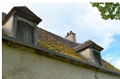
Détail des lucarne en capucine éclairant les combles à l'est. Phot. Maryse Durin-Tercelin IVR84_20250300590NUC4A
