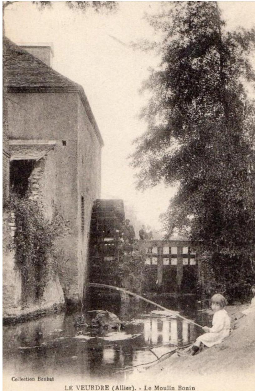
Le Moulin Bonin, sa roue, la passerelle et le vannage, vers 1935 : au tout premier plan à gauche on note la présence d'une haute cheminée.
