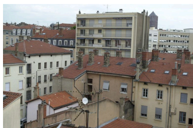
Vue de toiture Phot. Maryannick Chalabi IVR82_20096901134NUCA
