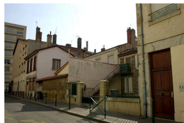
Vue d'ensemble depuis le sud-ouest Phot. Maryannick Chalabi IVR82_20096901106NUCA
