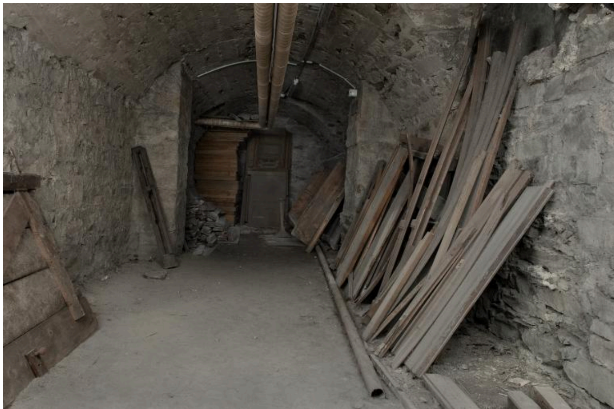
Boiseries démontées de l'ancienne chapelle, caves du lycée, vue générale
