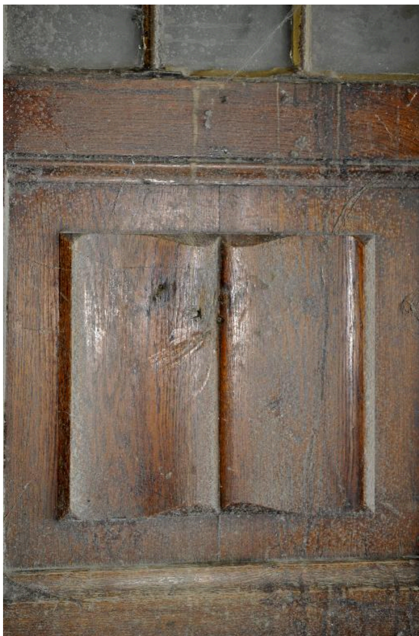
Vantail de la porte de la galerie, détail d'un panneau
