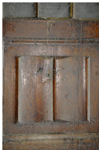
Vantail de la porte de la galerie, détail d'un panneau Phot. Catherine Guégan IVR82_20146902521NUCA
