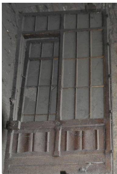
Vantail de la porte fermant la galerie reliant la porterie et le bâtiment principal, démonté et déposé dans une cave Phot. Catherine Guégan IVR82_20146902519NUCA
