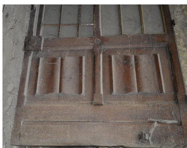
Vantail de la porte de la galerie déposé dans la cave, détail Phot. Catherine Guégan IVR82_20146902520NUCA
