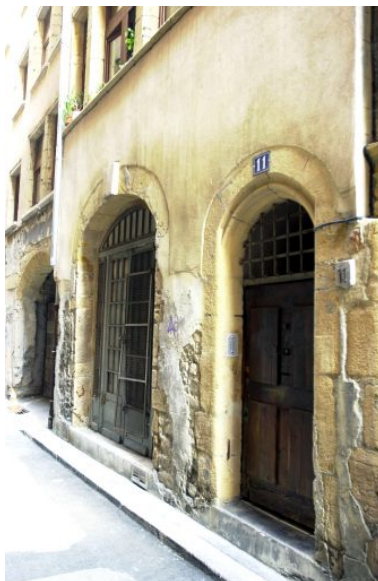
Façade, rez-de-chaussée Phot. Bernard Ducouret IVR82_20046900009NUCA
