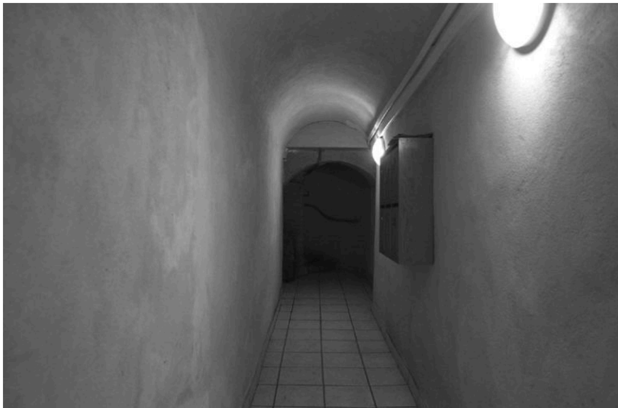
Allée, vue vers l'escalier
