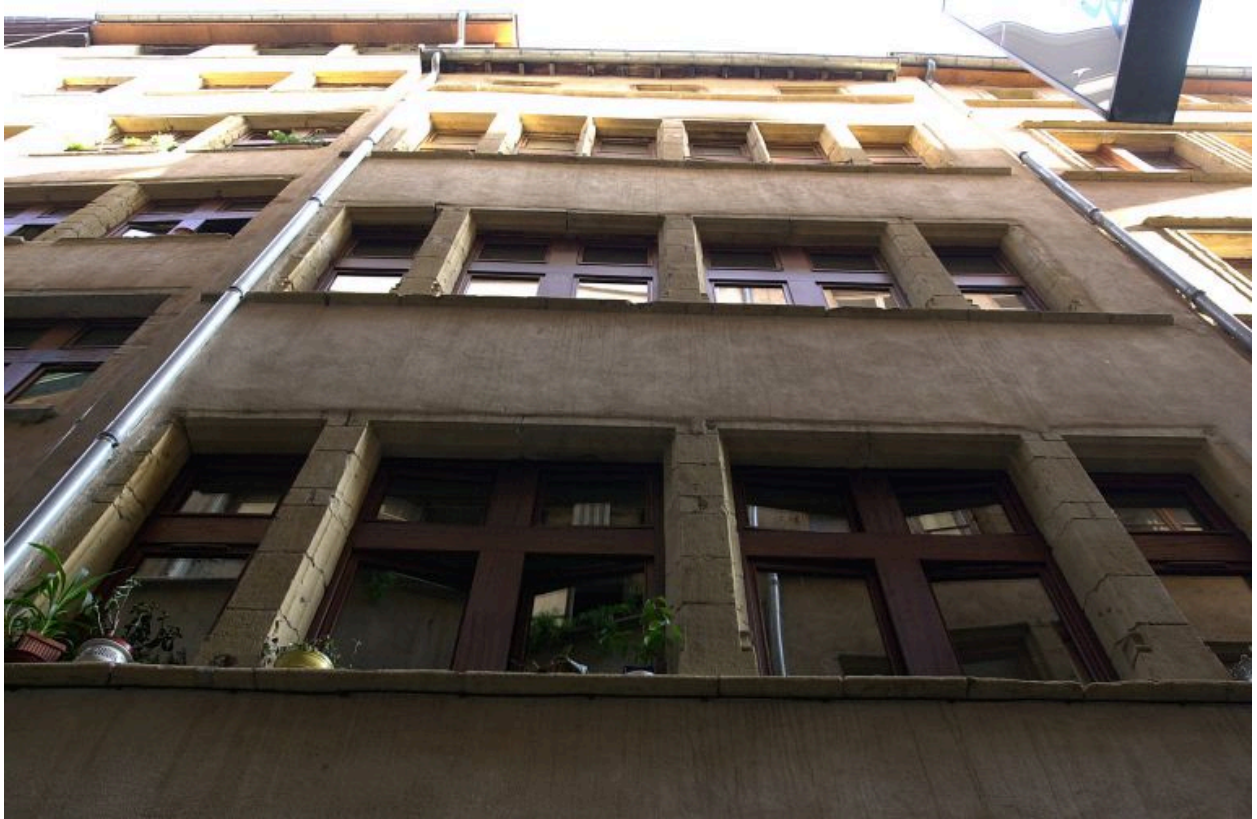
Façade, vue générale par-dessous
