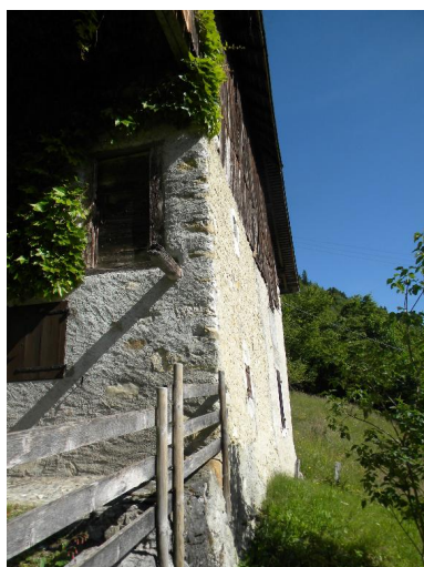
Vue du mir pignon est. Phot. Jérôme Daviet IVR82_20147400423NUCA
