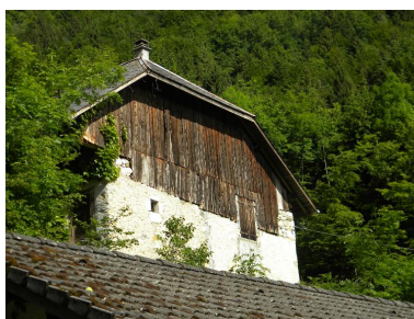
Vue d'ensemble du pignon est. Phot. Jérôme Daviet IVR82_20147400424NUCA
