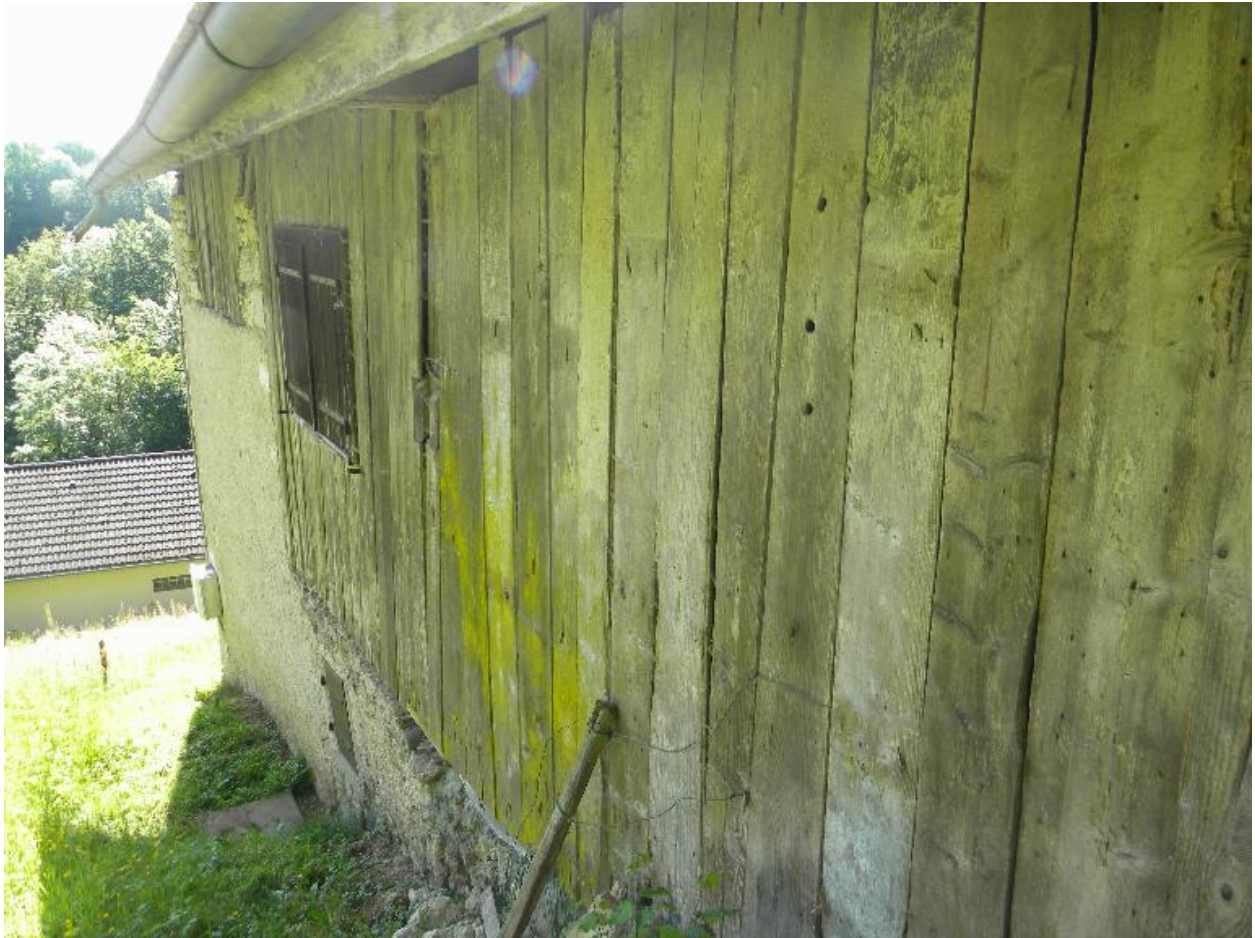
Vue de la façade arrière.
