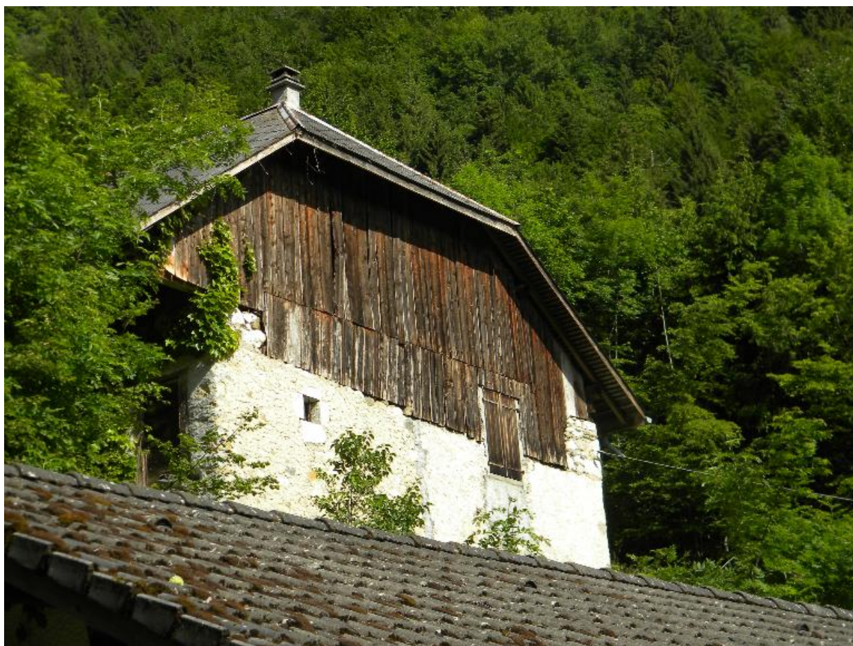
Vue d'ensemble du pignon est.
