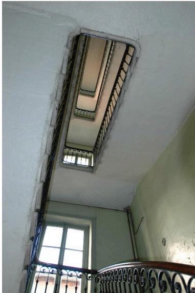
Vue de la cage d'escalier Phot. Catherine Guillot IVR82_20136900084NUCA
