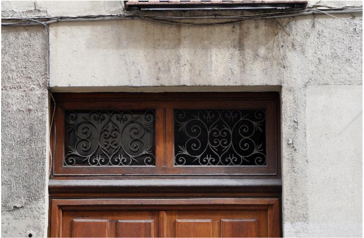
Détail de l'imposte en ferronnerie
