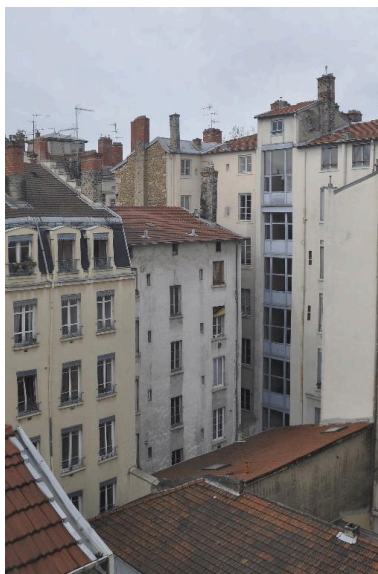
Elévation sur cour, vue générale Phot. Magali Delavenne IVR84_20166900686NUCA
