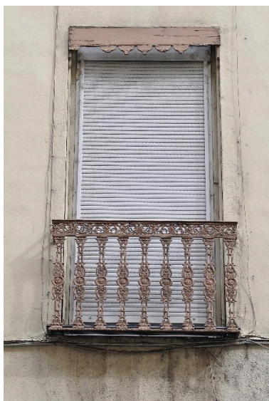
Détail d'une fenêtre du premier étage : garde-corps en ferronnerie Phot. Magali Delavenne IVR84_20166900685NUCA
