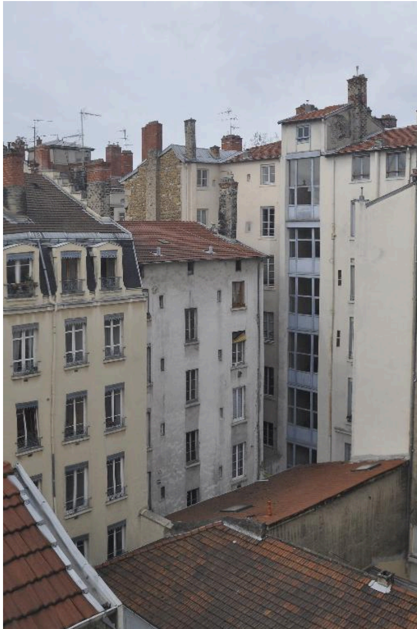
Elévation sur cour, vue générale
