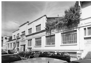
Vue générale sud Phot. Martial Couderette IVR82_20016903173P
