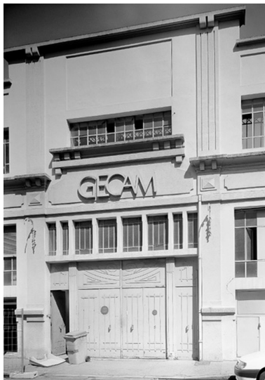
Entrée principale avec enseigne Phot. Martial Couderette IVR82_20016903174P
