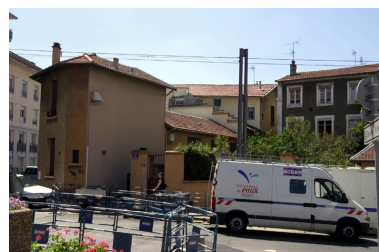
Vue d'ensemble nord Phot. Nadine Halitim-Dubois IVR82_20046902680NUCA
