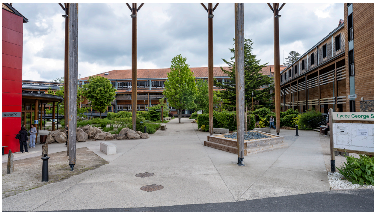
Vue d'ensemble, cour principale du lycée
