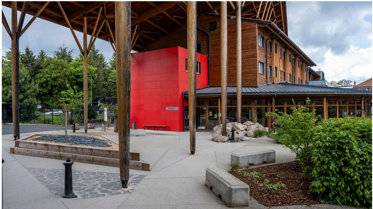
Vue d'ensemble de l'aménagement au niveau de l'entrée du lycée, depuis le sud-est
