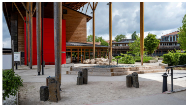
Vue rapprochée de l'aménagement au niveau de l'entrée du lycée, depuis le sud Phot. Michel Pérès IVR84_20254300173NUCA
