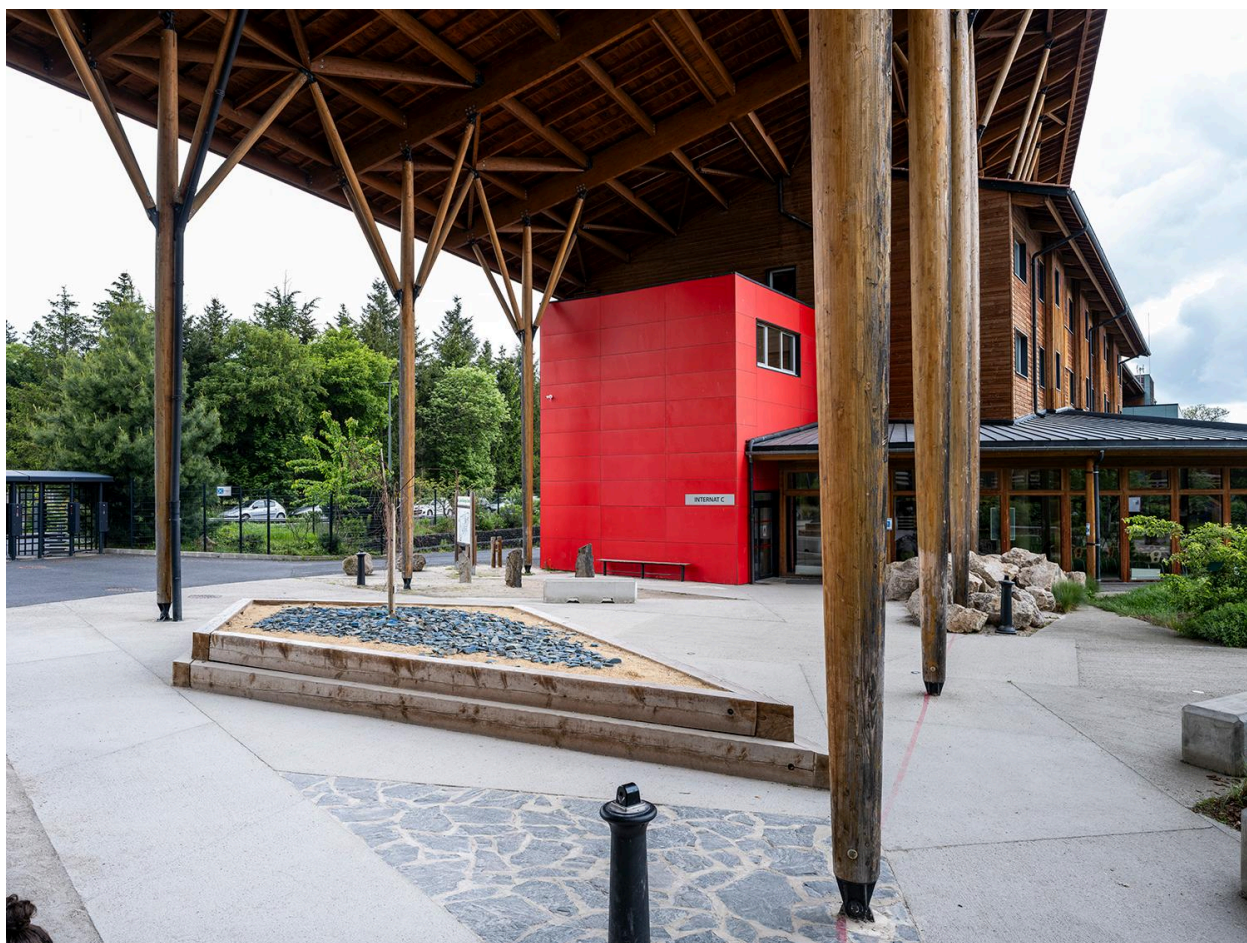
Vue de l'aménagement au niveau de l'entrée du lycée, depuis le sud-est
