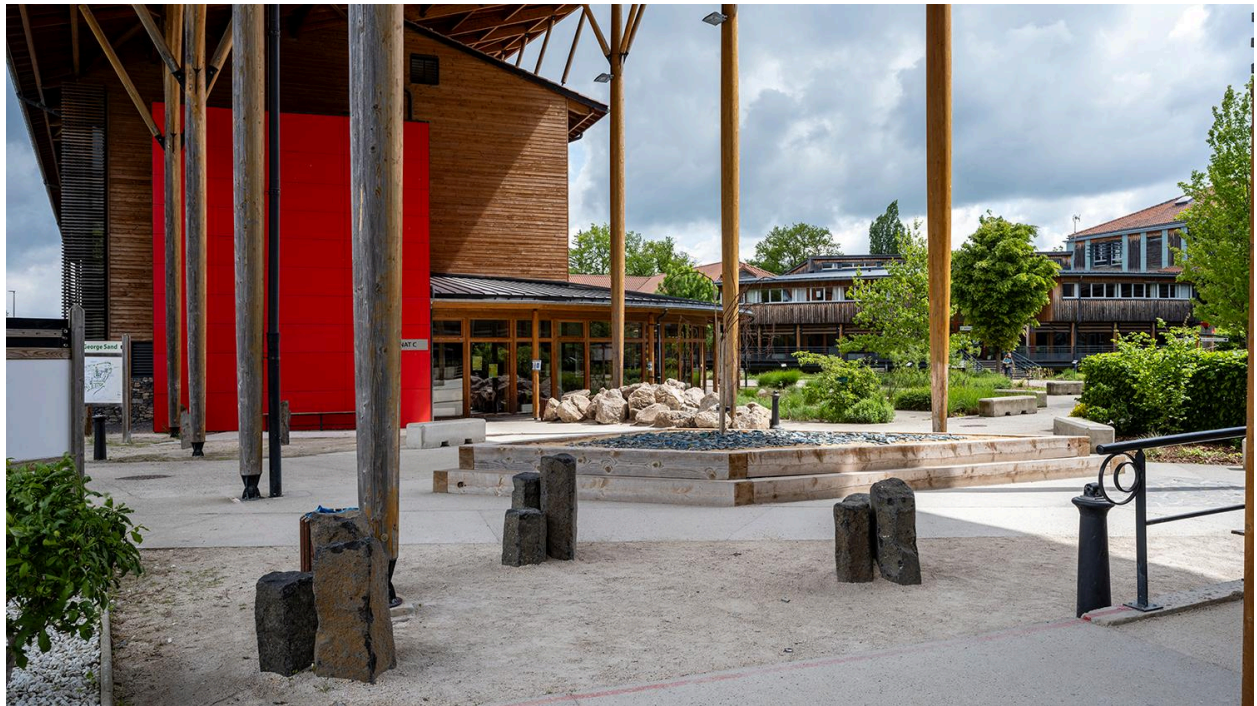
Vue rapprochée de l'aménagement au niveau de l'entrée du lycée, depuis le sud
