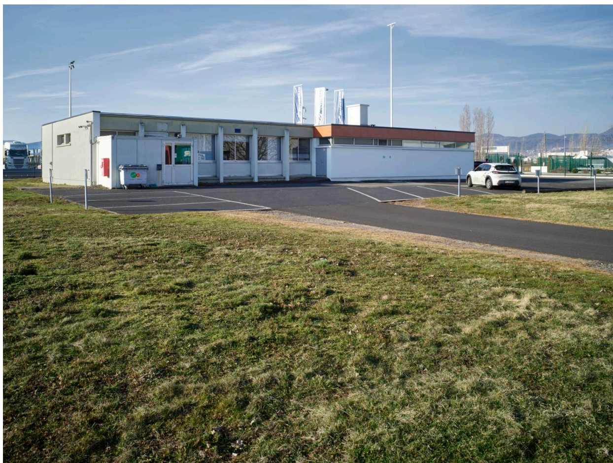
Le bâtiment TL22, ancien bureau des douanes désormais utilisé pour du stockage de fournitures, vu depuis le nord-est.
