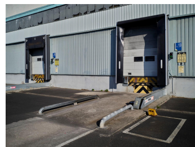
Quais de chargement des camions le long d'un entrepôt.
