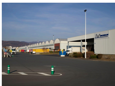
Vue générale du site depuis le sud-est. Au premier plan, le bâtiment TL16. Phot. Christian Parisey IVR84_20226300370NUCA
