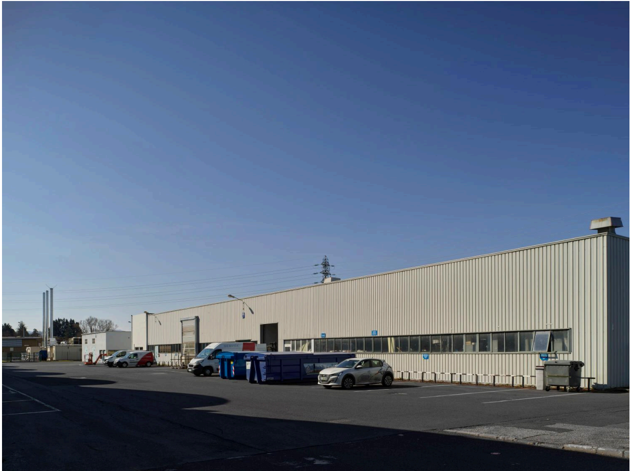
Le bâtiment W10 à l'ouest du site ; au second plan, B133.
