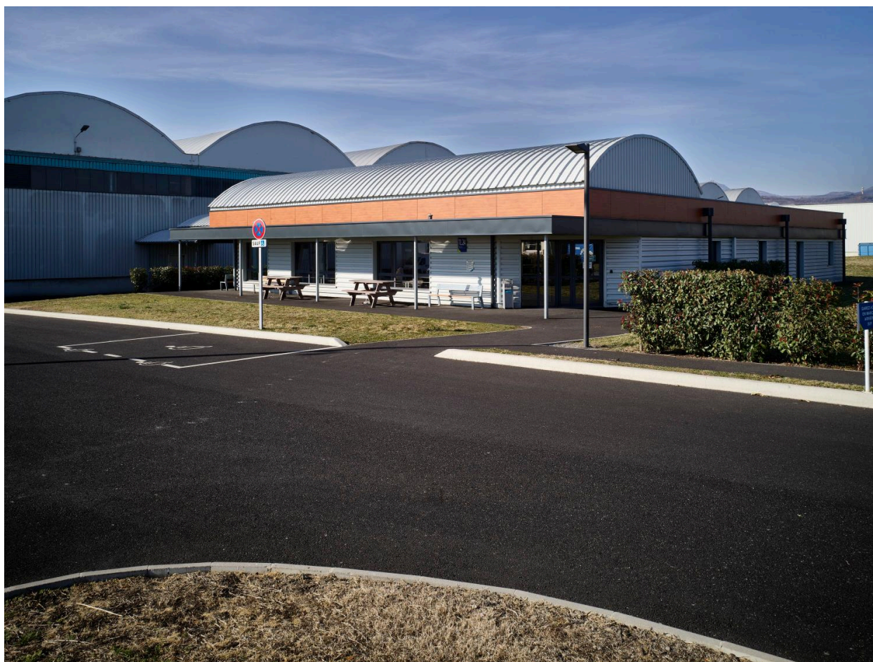
Le bâtiment TL24 (réfectoire, vestiaires) au nord du site.
