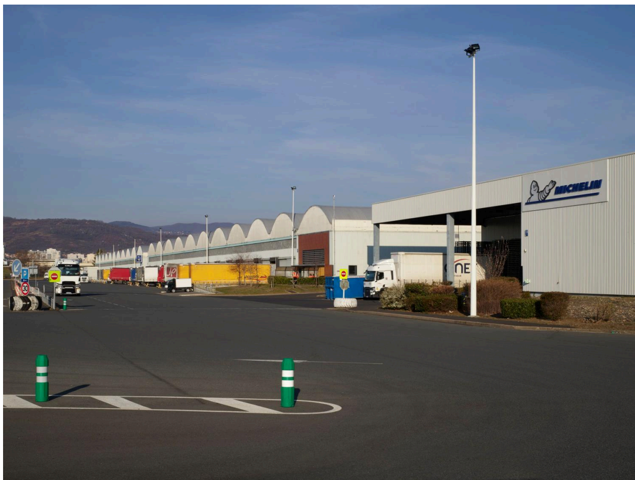
Vue générale du site depuis le sud-est. Au premier plan, le bâtiment TL16.
