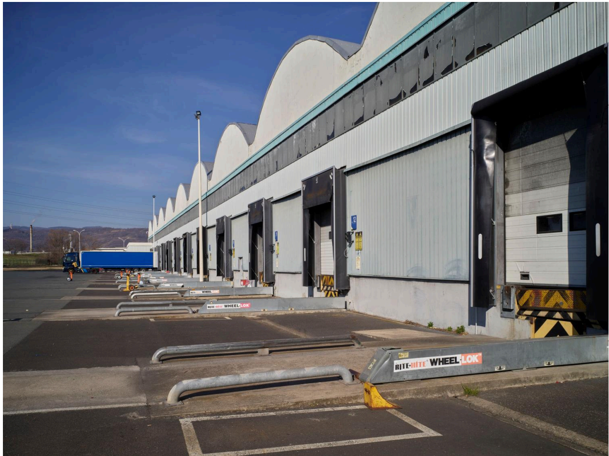
L'entrepôt TL11 et les quais de chargement des camions, le long du bâtiment.
