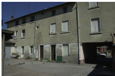
Vue de la façade sur cour Phot. François Blanchetière IVR82_20016901601NUCA
