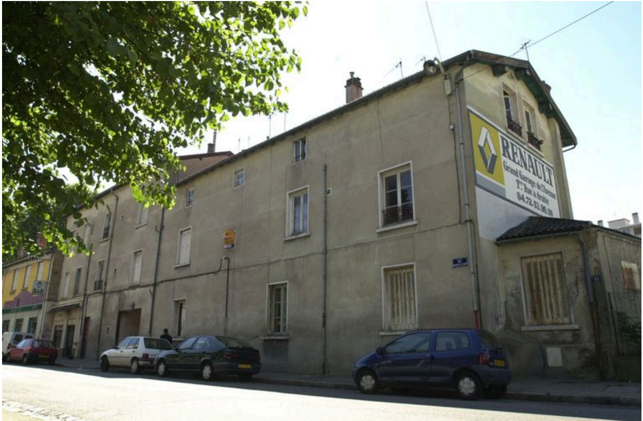
Vue de la façade depuis la rue Gorge-de-Loup
