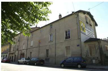
Vue de la façade depuis la rue Gorge-de-Loup Phot. François Blanchetière IVR82_20016901600NUCA
