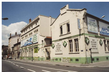
Vue d'ensemble sud-ouest Phot. Nadine Halitim-Dubois IVR82_20036901823ZA
