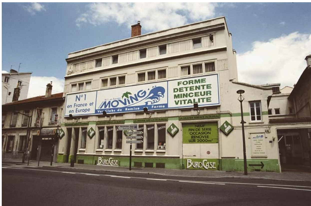
Façade usine de pâtes
