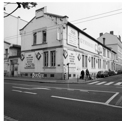
Vue de l'angle sud Phot. Martial Couderette IVR82_20026904469X
