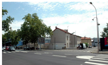
Vue de l'îlot 43 à 49 rue Edouard-Nieuport, 56 et 58 avenue Jean-Mermoz de puis le nord ouest Phot. Catherine Guégan IVR82_20076902213NUCA
